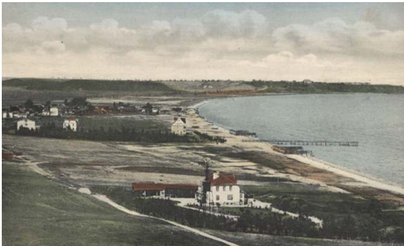
Budowa - Koszary MW, 1926
