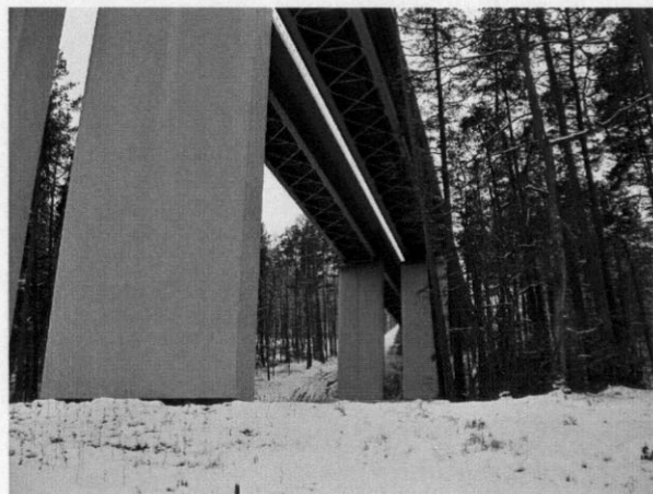
Wiadukt drogowy WD-2
