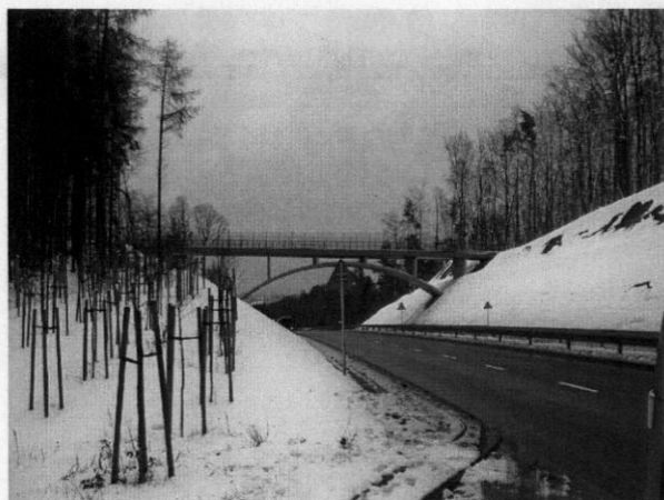
Kładka pieszo-jezdna nad Trasą Kwiatkowskiego
