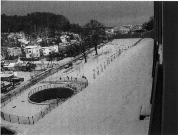
Zbiornik retencyjny przy WD-1 widok na ul. Leszczyński
