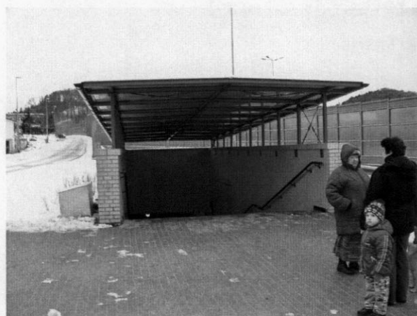
Wyremontowane przejście podziemne
