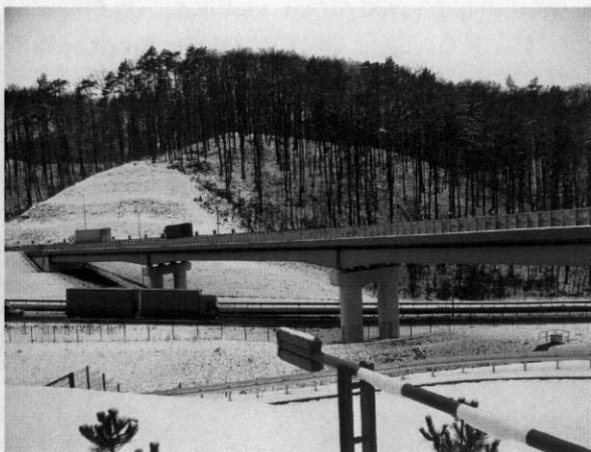
Wiadukt drogowy WD-3
