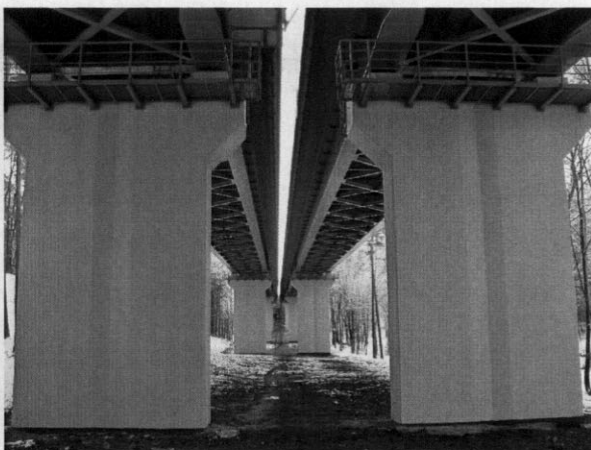
Wiadukt drogowy WD-1
