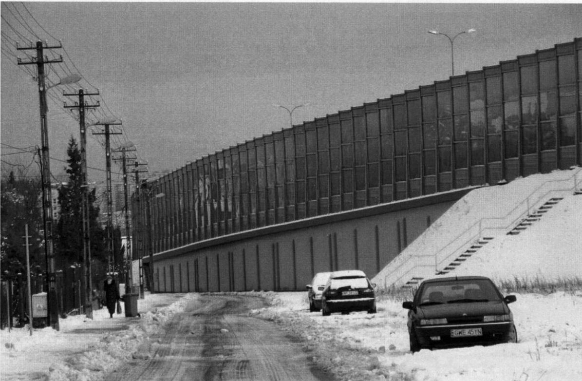
Ekrany dźwiękochłonne na murze oporowym przy ul. Leszczyński
