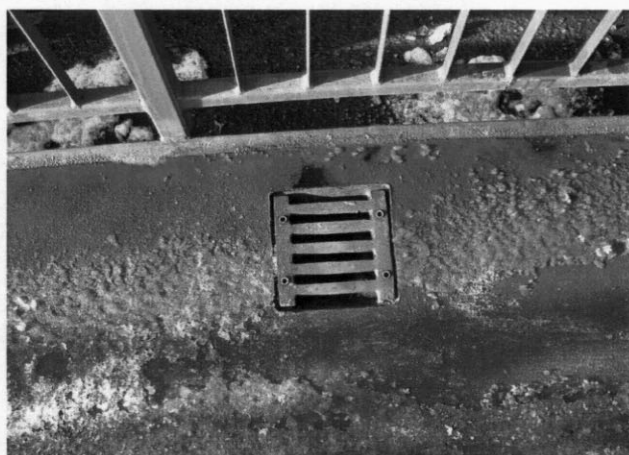
Odwodnienie wiaduktu
