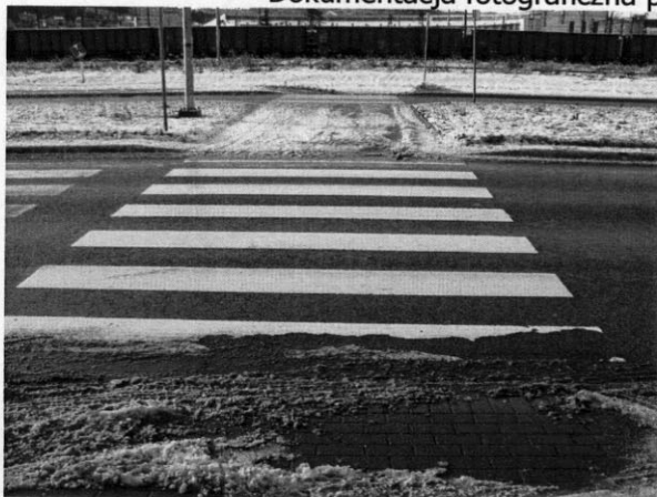
Przejście dla pieszych (obniżone krawężniki)
