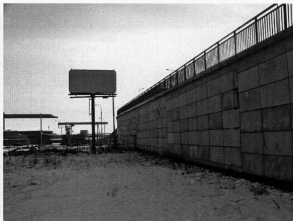
Mur oporowy przy wiadukcie
