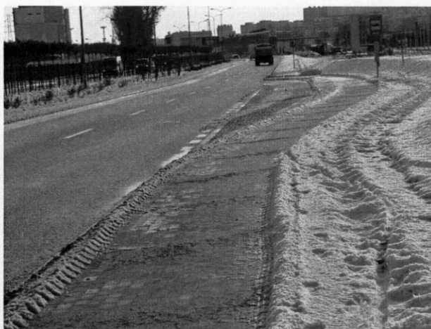
Zatoka autobusowa i ścieżka rowerowa – ul. J. Wiśniewskiego
