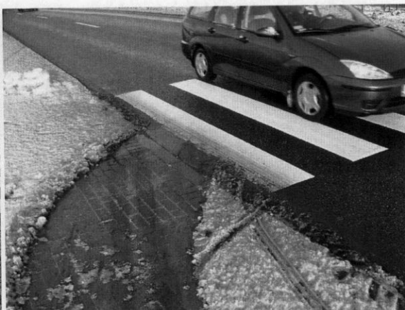
Obniżenia krawężników na przejściu dla pieszych
