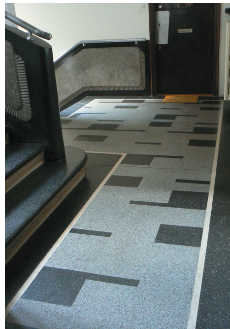
Posadzka klatki schodowej wykonana z różnobarwnego lastrico
