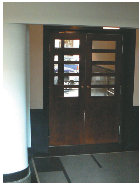
Klatka schodowa budynku – drzwi wewnętrzne
