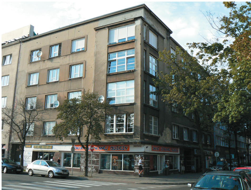
Kamienica przy ul. Abrahama 28, stan obecny
