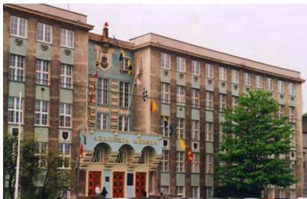
34. Zespół budynków dawnej Szkoły Morskiej
