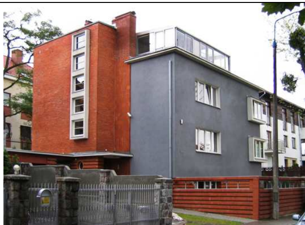
17. Willa modernistyczna, Kamienna Góra
