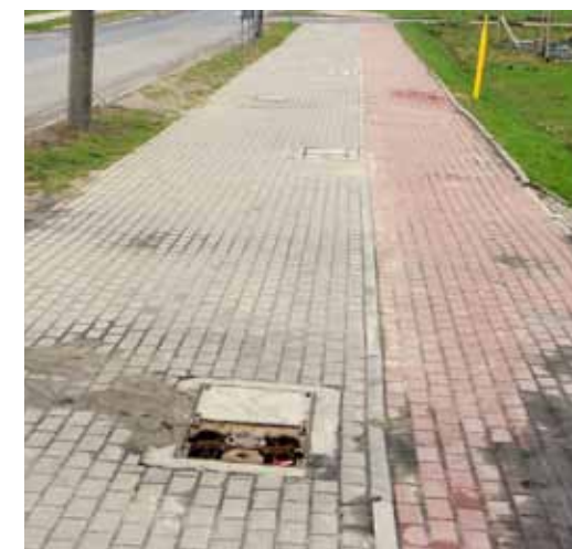
Brak konsekwencji w zastosowanej kolorystyce (dla rowerzystów przeznaczona jest część z kostki w kolorze szarym) oraz zniszczenia nawierzchni drogi rowerowej w ul. Wiczlińskiej
