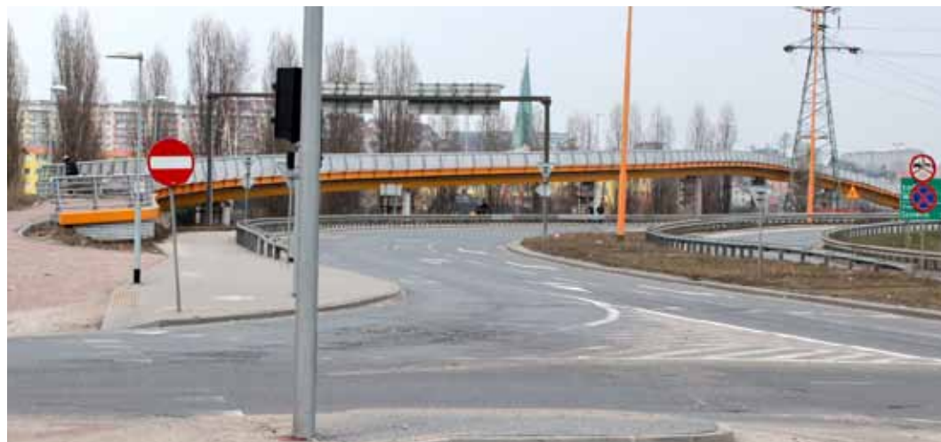
Estakada rowerowa na ul. Kwiatkowskiego w trakcie budowy (kwiecień 2013).
