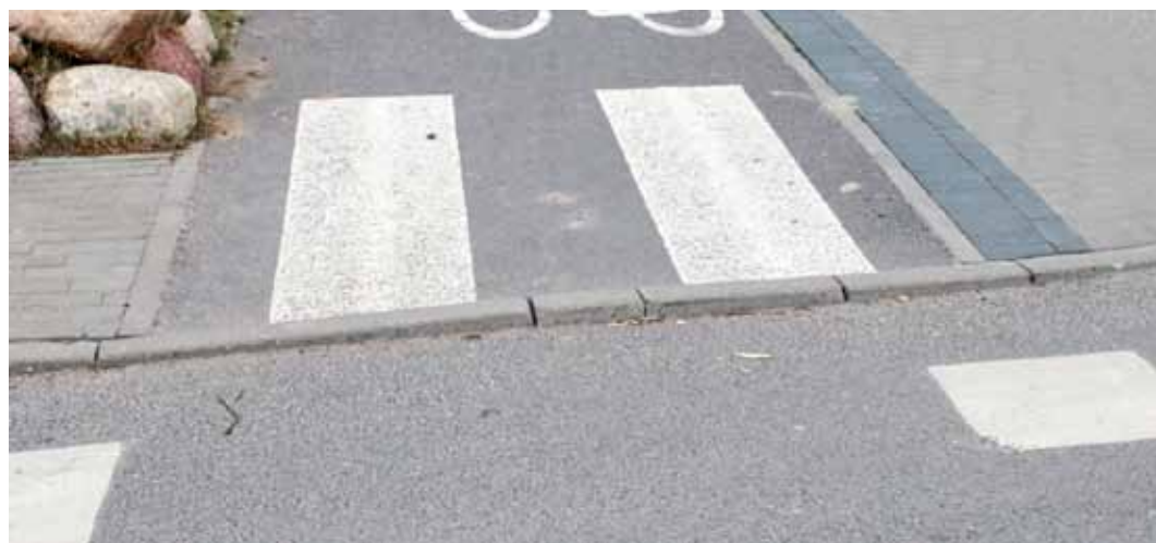
Krawężnik na przecięciu drogi rowerowej w ul. Bosmańskiej z ul. Granatową
