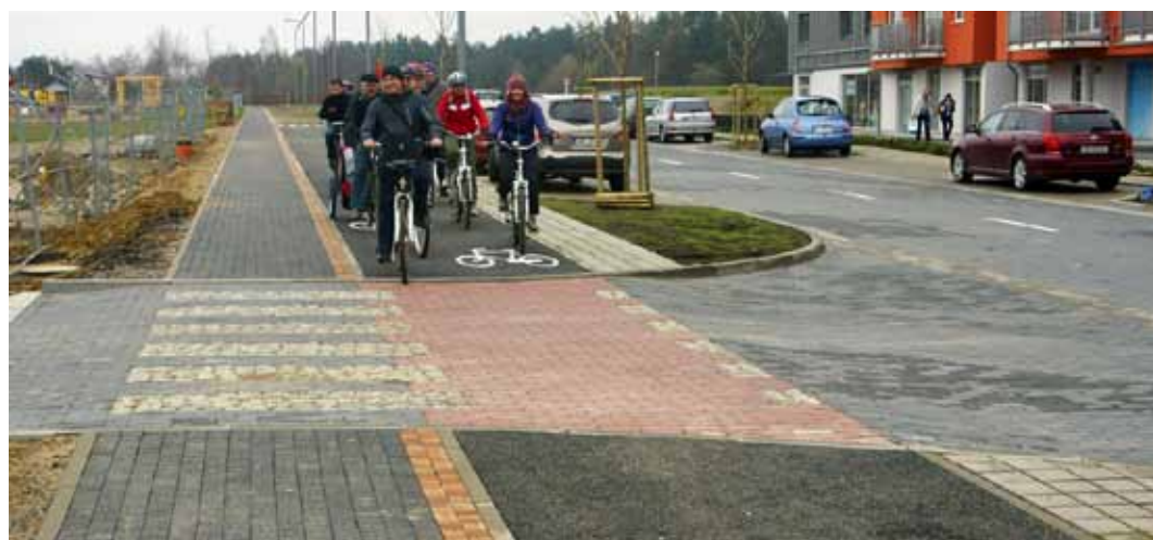
Ul. Filipkowskiego – wydzielona droga rowerowa wzdłuż osiedlowej ulicy
