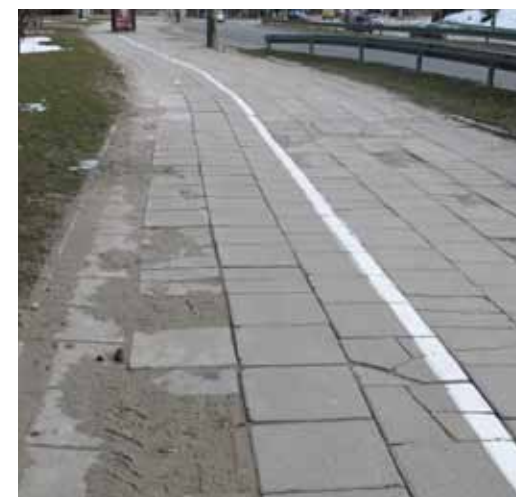
Droga rowerowa w ciągu ul. Wielkopolskiej – ul. Chwaszczyńskiej składająca się z licznych fragmentów o różnej nawierzchni
