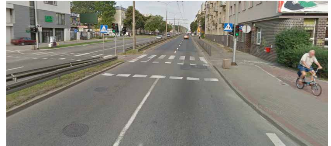
Droga rowerowa w ul. Morskiej, zmieniająca na odcinku długości 1,7 km trzykrotnie stronę, po której biegnie (źródło: Google Street View)
