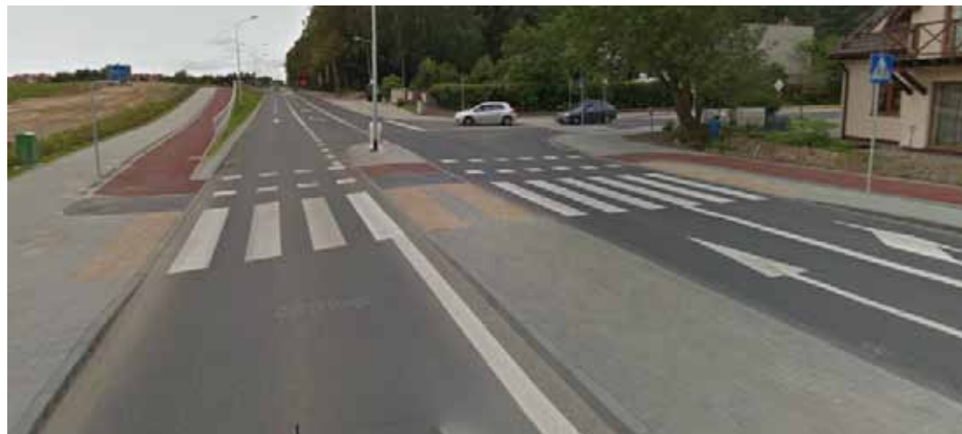
Przebudowany odcinek ulicy Chwarznieńskiej: dla samochodów prosta jezdnia, dla rowerzystów wydłużona droga z ciasnymi łukami i potencjalnie niebezpieczne punkty kolizji (źródło: Google Street View)
