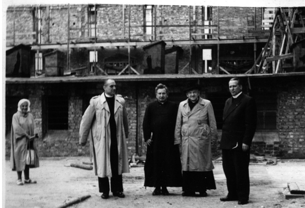
Budowa kościoła NSPJ - rok 1959
