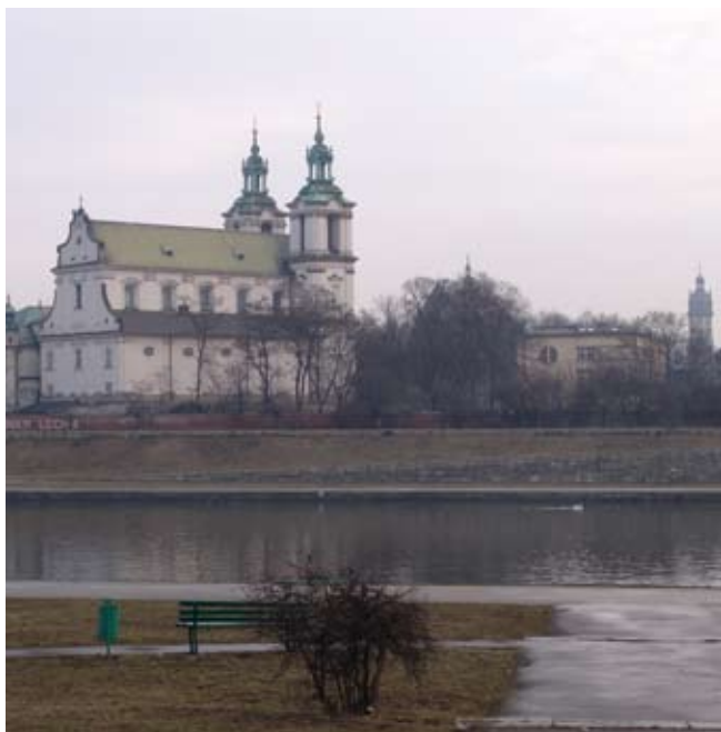
6. Kraków, kościół p.w. św. Stanisława B. i M. oraz Seminarium Duchowne oo. Paulinów przy ul. Skalecznej, Adolf Szyszko-Bohusz 1931, elewacja zachodnia. Fot. autor.
