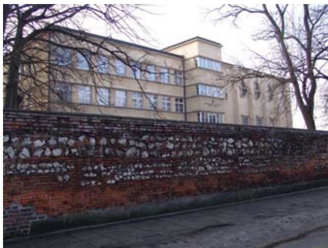
8. Kraków, Seminarium Duchowne oo. Paulinów przy ul. Skalecznej, Adolf Szyszko-Bohusz 1931, elewacja północna. Fot. autor.
