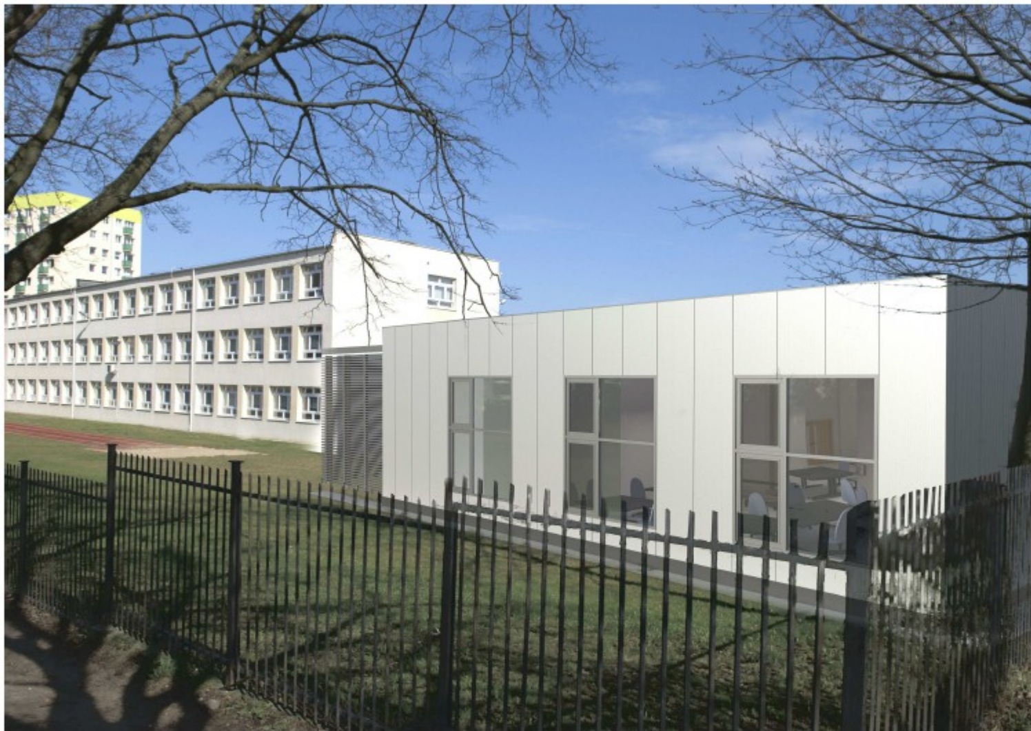
Widok na pawilon warsztatowy z ulicy Morskiej
