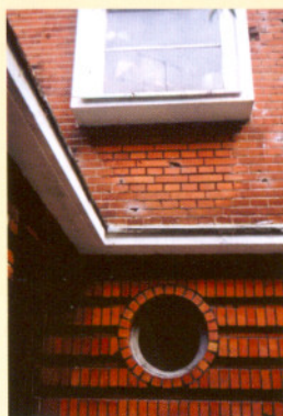
Okno willi przy ul. Sieroszewskiego 1a
