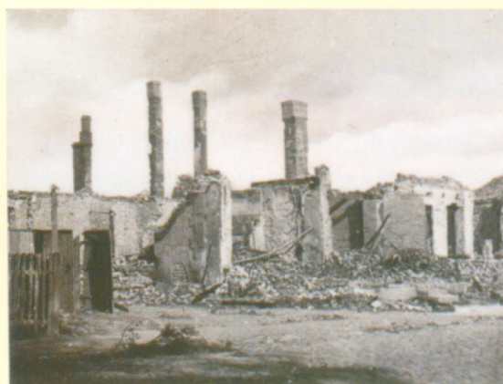
2. Zniszczone domy na Kępie Oksywskiej, 1939 r.
