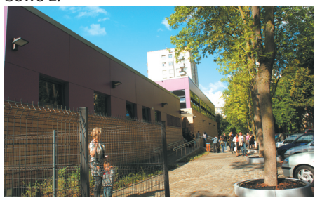
Nowa sala gimnastyczna przy SP 18
