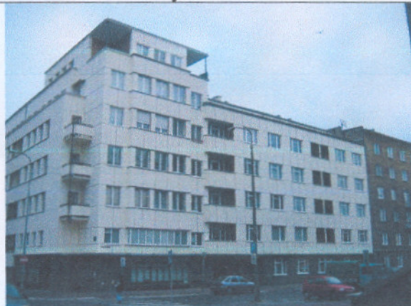
Dom ul. 3 Maja 27-31 – renowacja okien
