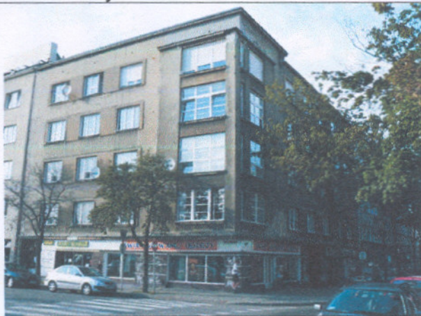
ul. Abrahama 28 - elewacje
