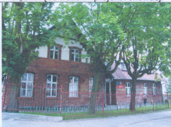
Ul. Lubawska 4 – remont dachu
