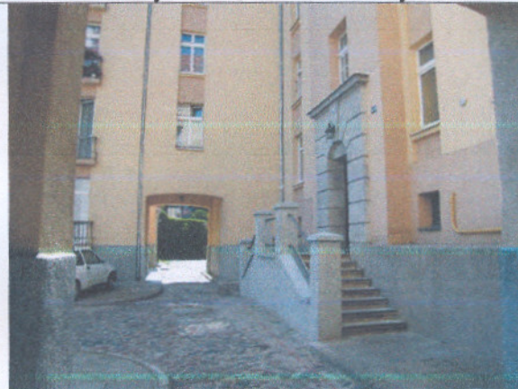
Dom ul. Morska 67 – bruki podwórza
