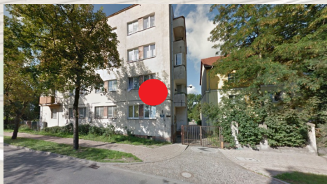
Schron przeciwlotniczy pod budynkiem mieszkalnym (ul. Chrzanowskiego 14)
