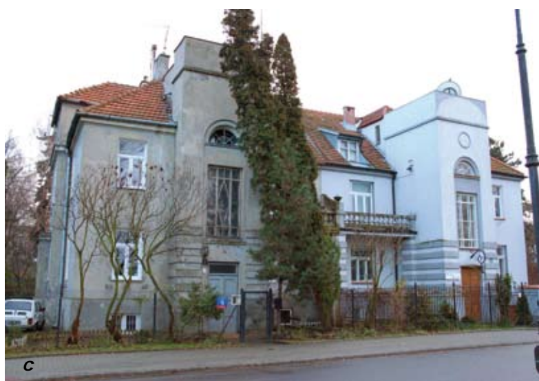
14. Warszawa, Żoliborz, Spółdzielnia Mieszkaniowa „Osiedle Wojskowe”, proj. R. Feliński. a. Placyk na osi założenia, ul. Dygasińskiego; b. Budynek, ul. Promyka 9; c. Typowy budynek, ul. Dygasińskiego 16. Fot. J. Lewicki 2006.
