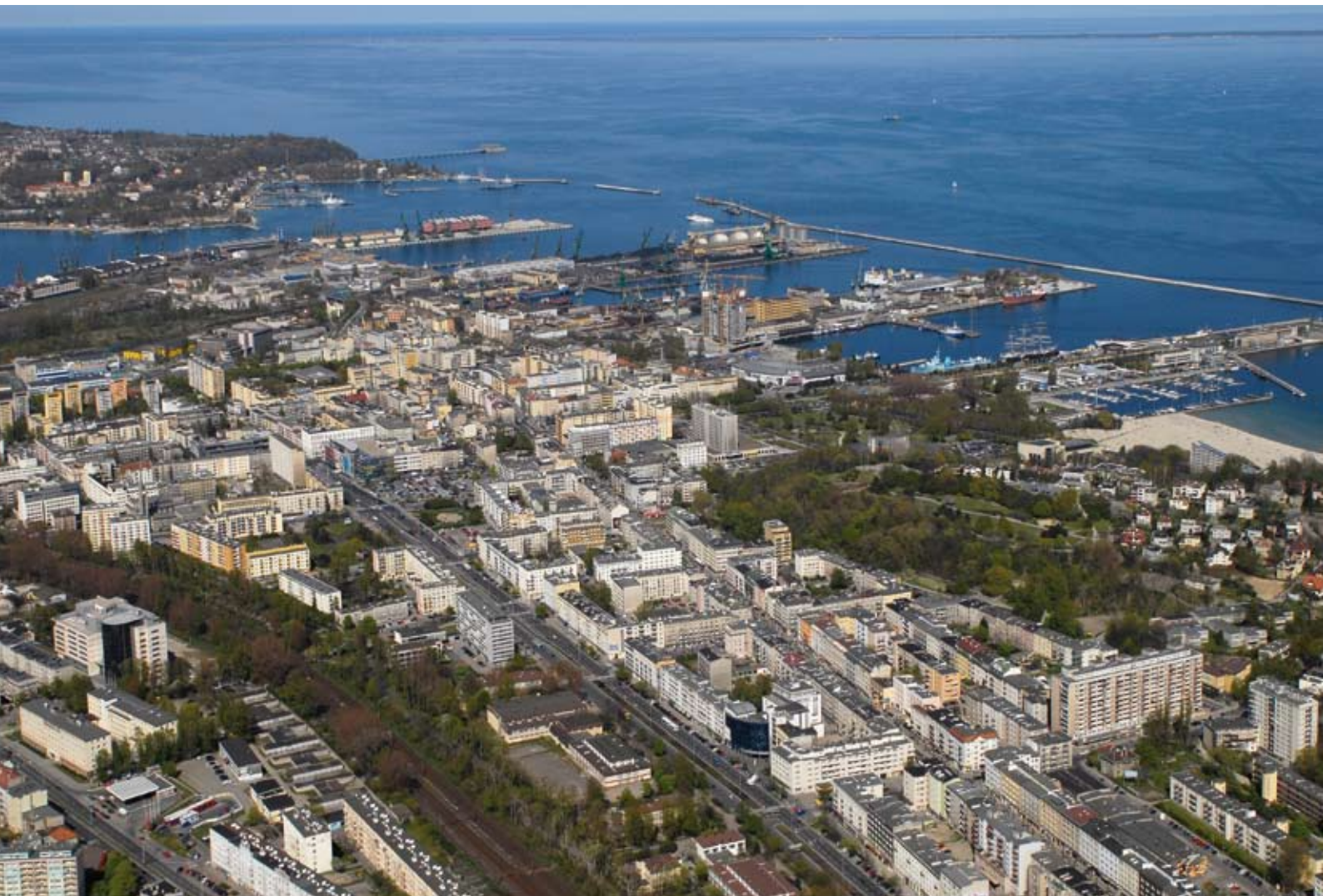
5. Śródmieście Gdyni objęte we wrześniu 2007 r. wpisem do rejestru zabytków. Fot. W. Stępień
