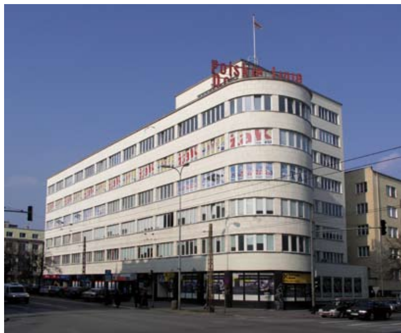
6 Budynek biurowy dawnego Zakładu Ubezpieczeń Pracowników Umysłowych (później Polskich Linii Oceanicznych) w Gdyni. Fot. T. Błyskosz, ROBiDZ w Gdańsku.
