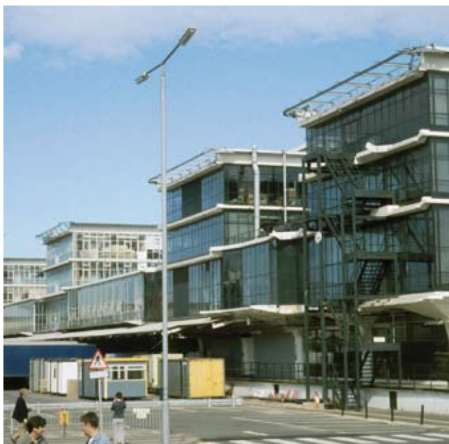
3. Fabryka Boots D10, Nottingham, Anglia, wg projektu Owena Williama, 1933, za modernizowaną fasadą widać fragmenty jeszcze nie poddane modernizacji, 1996. (Fot. autor)
