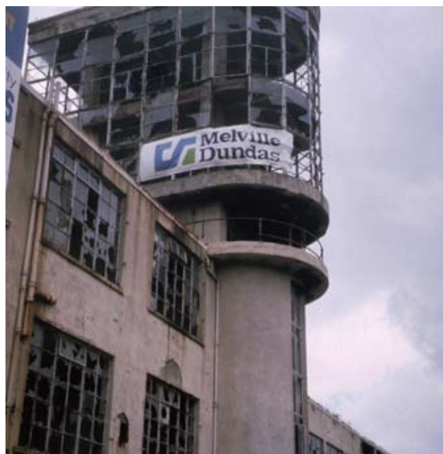
7. Zakłady Luma Lamp , Glasgow, 1996, początek prac adaptacyjnych. (Fot. autor)
