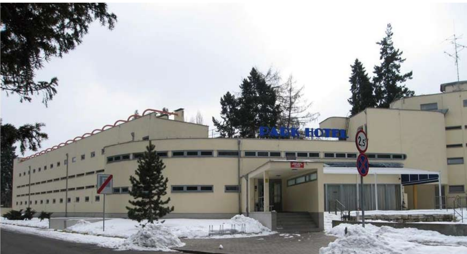
5. Budynek po remoncie elewacji, widok od strony ulicy, stan z 2005. Fot. B. Dubik
