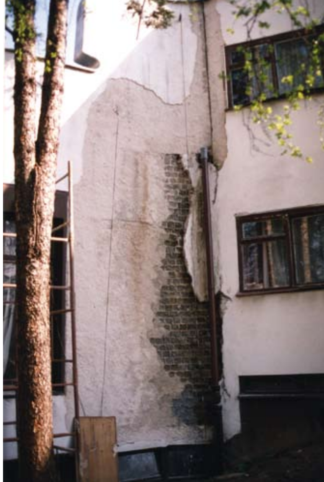
3. Zawilgocenie ścian na styku lewego skrzydła i części środkowej, stan z 1993. Fot. J. Urbanik
