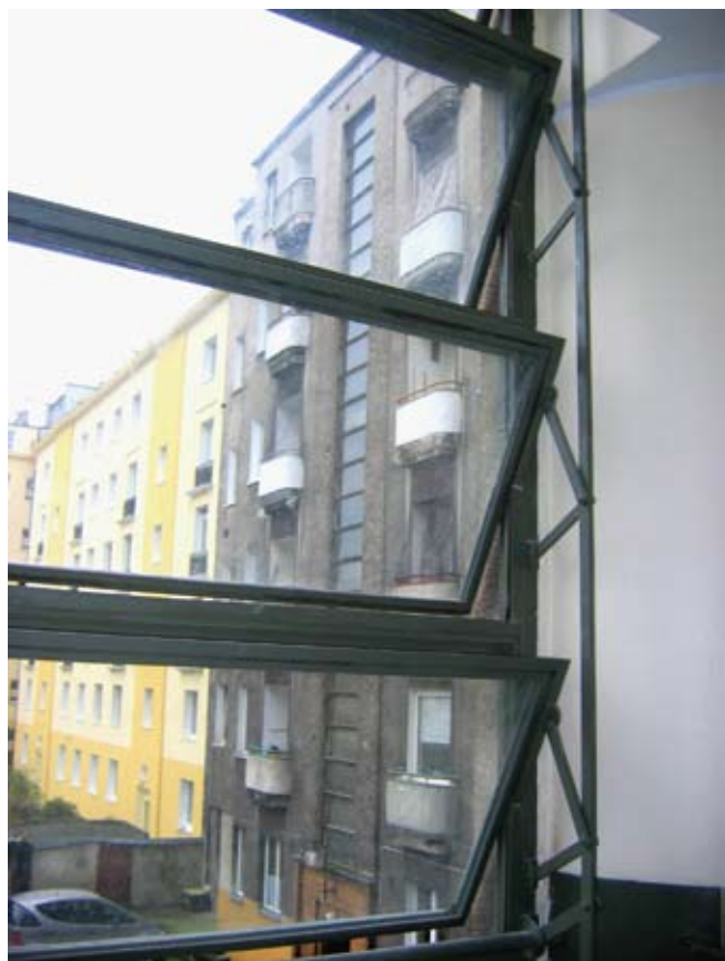
6. Obrotowe okna klatki schodowej budynku przy ul. 3 Maja 27-31 po odrestaurowaniu w 2007 r., fot. R. Hirsch
