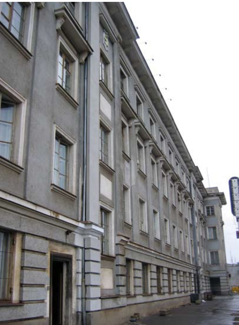
3. Dworzec kolejowy w Gdyni, fragment elewacji północno-zachodniej, fot. R. Hirsch
