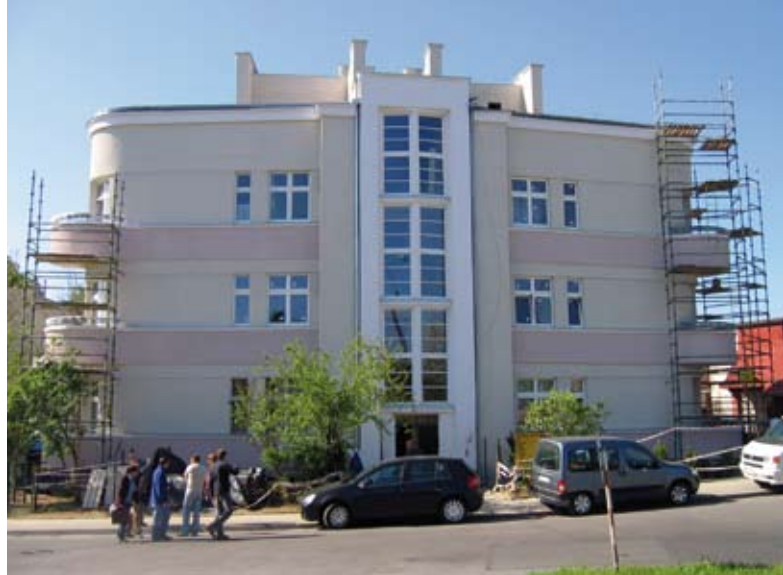
13. Budynek mieszkalny „Opolanka” po pracach restauratorskich przeprowadzonych w 2007 r., fot. R. Hirsch
