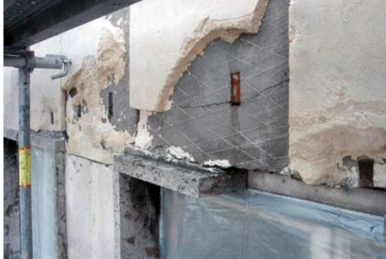
4. Zniszczona okładzina kamienna elewacji budynku dawnego FE BGK przy ul. 3 Maja 27-31 w Gdyni, fot. R. Hirsch
