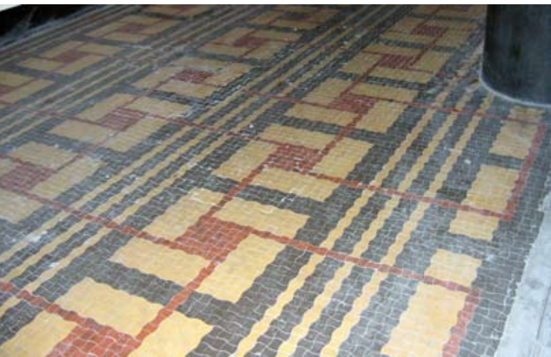
5. Posadzka z drobnowymiarowych płytek ceramicznych w bramie budynku dawnego FE BGK przy ul. 3 Maja 27-31 w Gdyni w trakcie uzupełniania w 2006 r., fot. R. Hirsch
