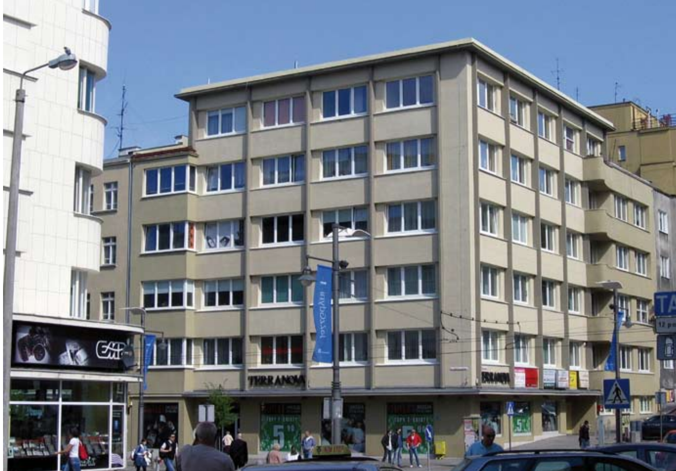
11. Zabytkowa kamienica Krenskich przy ul. Świętojańskiej 55 w Gdyni, po remoncie przeprowadzonym w roku 2006, fot. R. Hirsch
