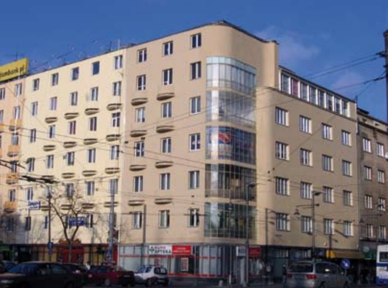
12. Kamienica przy ul. Świętojańskiej 122 po pracach restauratorskich przy elewacjach przeprowadzonych w latach 2006-2007, 2007 r., fot. R. Hirsch
