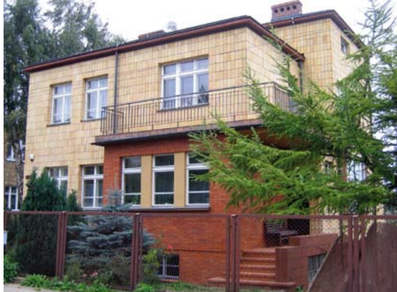
14. Zabytkowa willa przy ul. Inżynierskiej 111 po pracach restauratorskich przeprowadzonych w latach 2007-2008, fot. R. Hirsch
