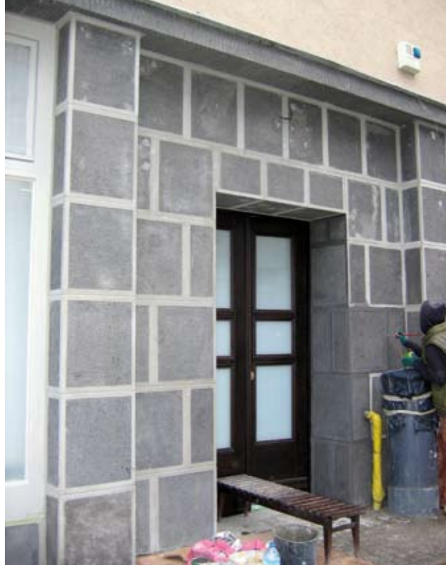
9. Prace restauratorskie przy zabytkowych tynkach parteru kamienicy przy ul. Świętojańskiej 122, fot. R. Hirsch
