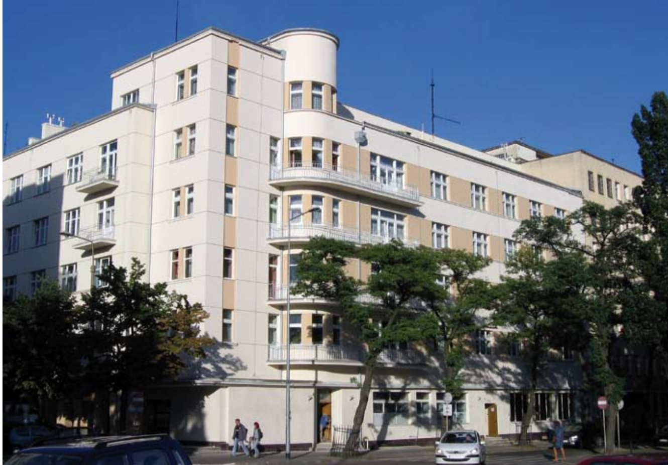
10. Zabytkowa kamienica Pręczkowskich przy Skwerze Kościuszki 10-12 po remoncie przeprowadzonym w latach 2005-06, fot. R. Hirsch
