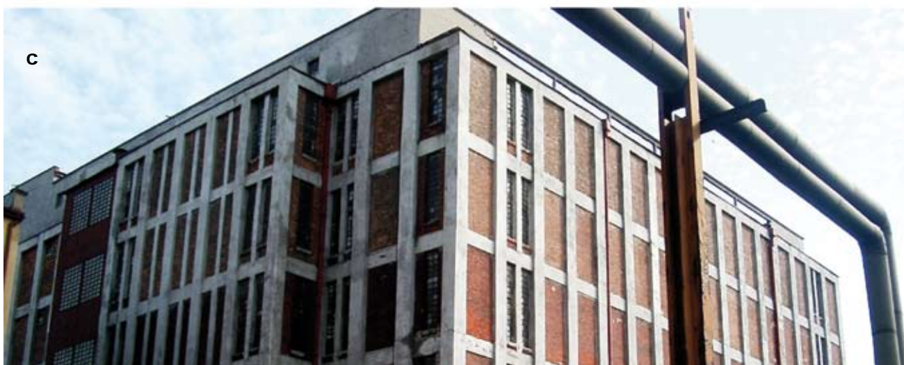
4. Chłodnia śledziowa, nb. Angielskie, budowa (I etap) 1935-36 r., (II etap) 1960-65 r. a. fotografia archiwalna z lat 30. XX w. (ze zbiorów Muzeum Miasta Gdynia); b. widok chłodni od strony nabrzeża; c. siatka żelbetowych ram konstrukcyjnych z ceglany wypełnieniem lica - fragment szczytu budynku chłodni (fotografie współczesne A. Orchowska-Smolińska)
