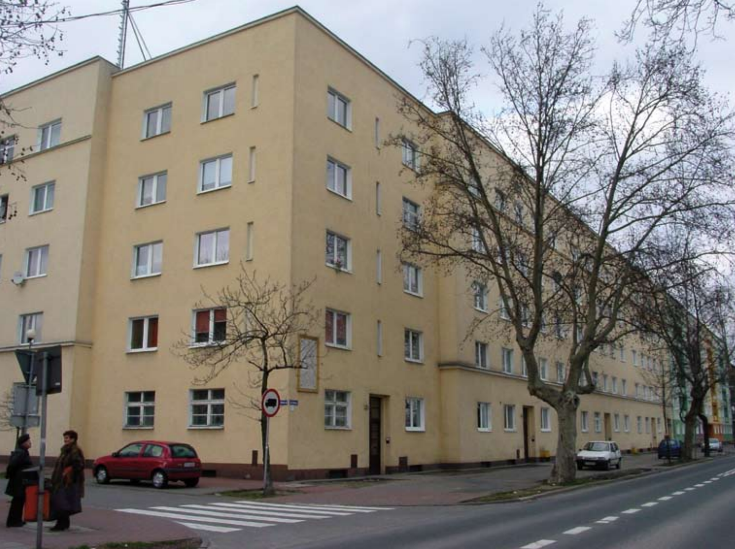
7. Blok Kasy Emerytalnej dla Robotników Kolei Państwowych przy ul. Rolnej 50-52 w Poznaniu, arch. Jerzy Tuszowski, 1928-1929 (fot. autorki)
