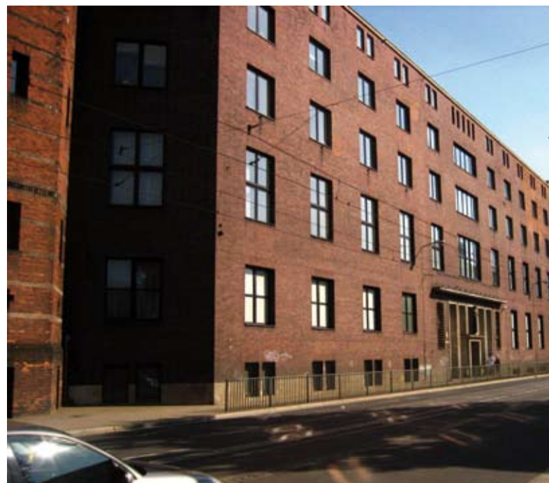
5. Werner Haberland, nowe skrzydło budynku sądu przy ul. Sądowej 1-3, zbudowane VII.1930 - II.1934 r. (fot. autor, 2009).
