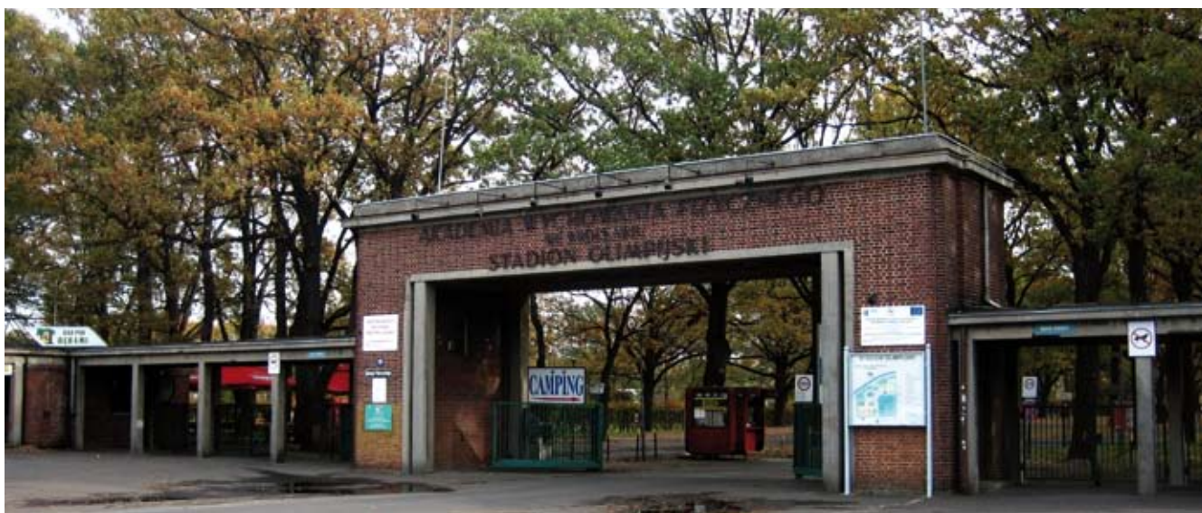
9. Richard Konwiarz, Stadion Olimpijski, nowa budowla bramna (fot. autor, 2009).
