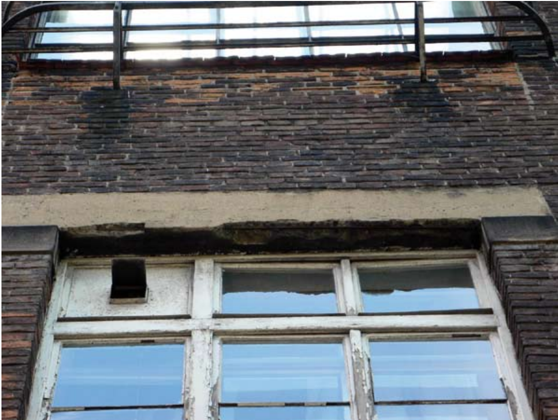
7. Kraków, Wydział Form Przemysłowych ASP, elewacja tylna, szczegół żelbetowej belki nadokiennej z widocznym ubytkiem otuliny betonowej pręta zbrojeniowego; można to interpretować, jako skutek niewłaściwego wykonania lub korozji spowodowanej upływem ponad 90-ciu lat. Fot. W. Affelt (czerwiec 2009 r.)
