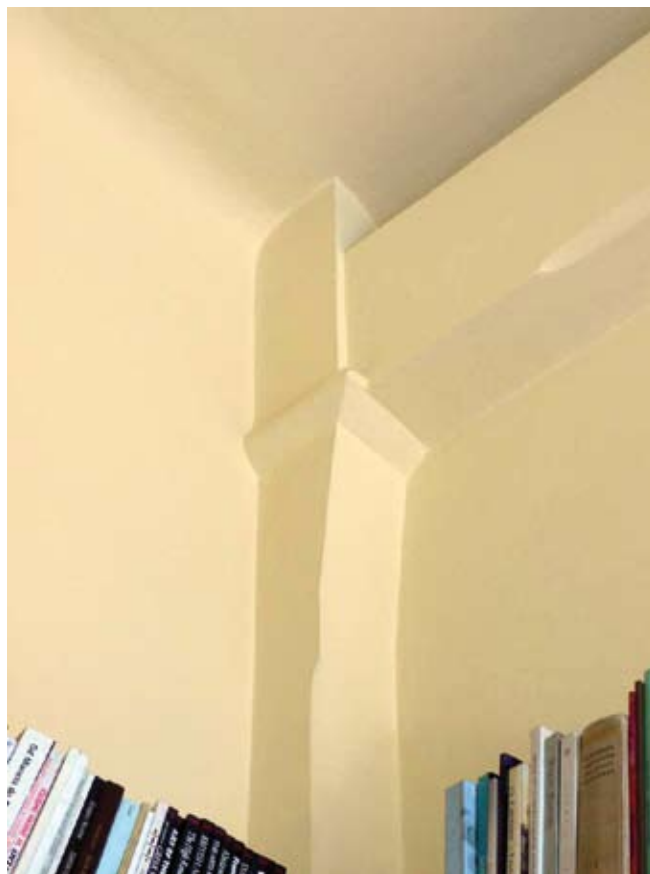
5. Kraków, Wydział Form Przemysłowych ASP, wnętrze pokoju (prawdopodobnie po przebudowie), szczegól oparcia podciągu na słupie; warto zauważyć formę krawędzi elementów żelbetowych naśladowującą tradycyjną obróbkę ciesielską. Fot. W. Affelt
