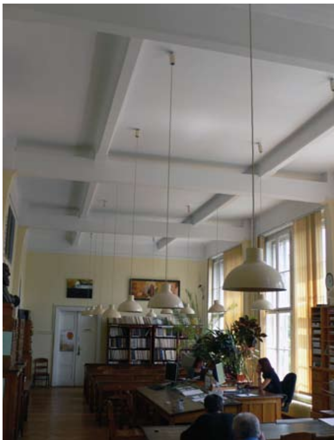
4. Kraków, Wydział Form Przemysłowych ASP, czytelnia; konstrukcja stropu, którego belki spoczywają na podciągach poprzecznych, opartych na słupach przylegających do filarów międzyokiennych. Fot. W. Affelt
