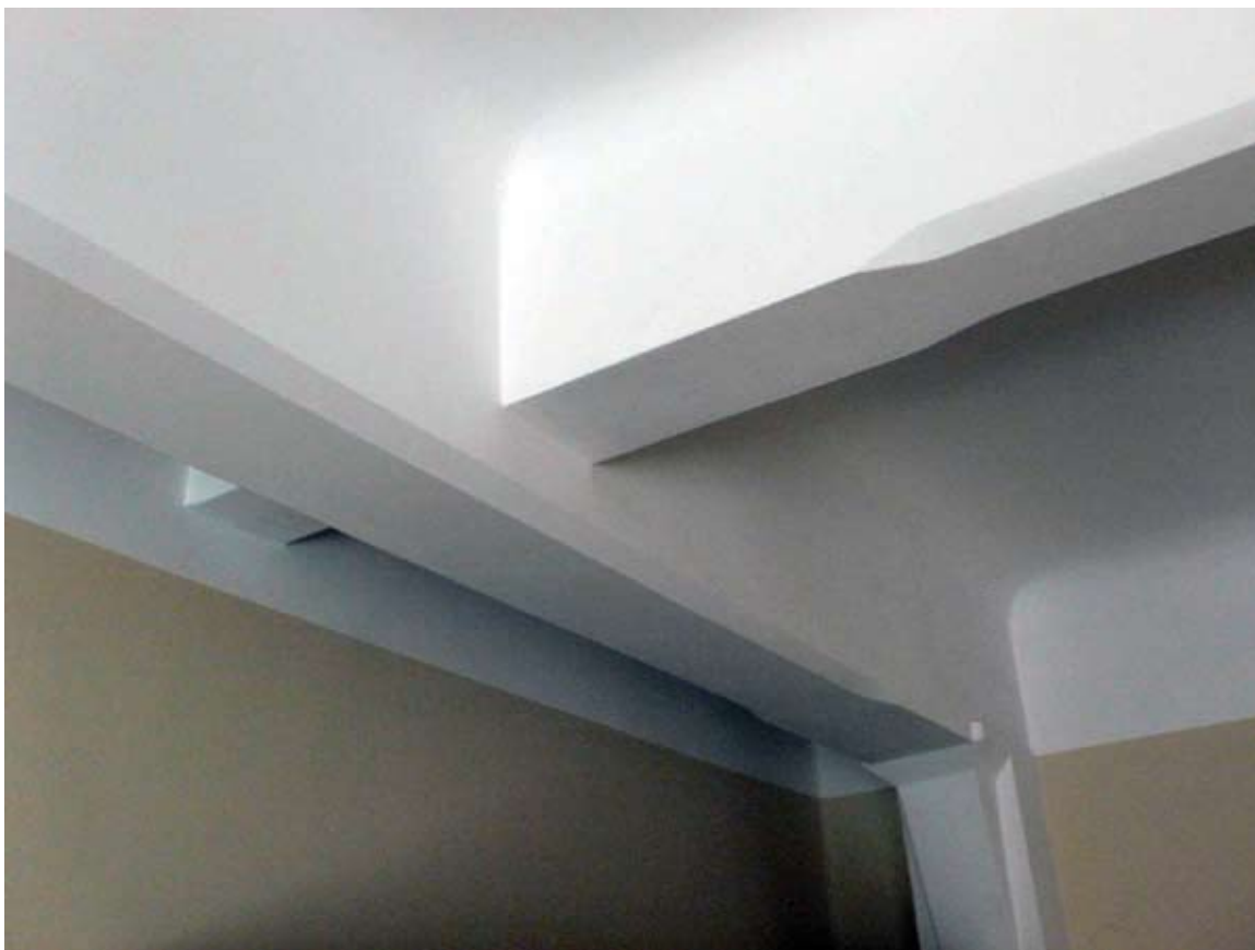
6. Kraków, Wydział Form Przemysłowych ASP, szczegół masywnego stropu żelbetowego; zwraca uwagę forma krawędzi elementów żelbetowych naśladująca tradycyjną obróbkę ciesielską. Fot. W. Affelt
