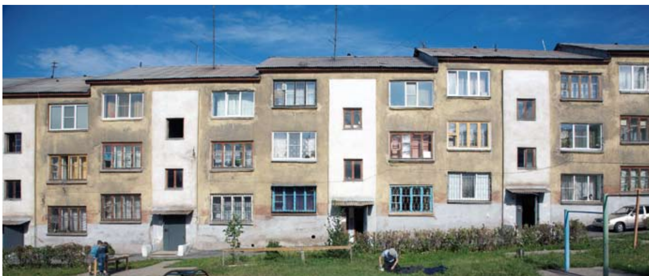
9, 10. Jeden z wykupionych na własność przez mieszkańców i odnowionych budynków, fot. autor
