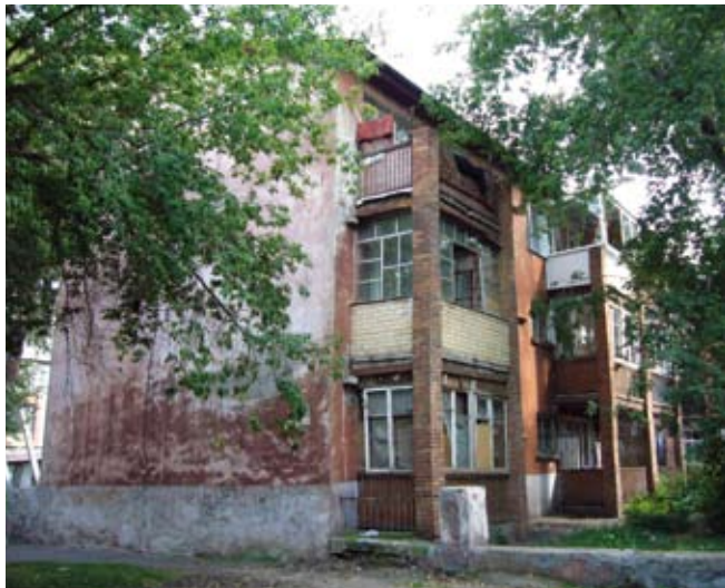
6. Widok szeregowych bloków mieszkalnych w części północno-wschodniej dzielnicy, wg proj. Czernyszewa poprawionego przez zespół Maya, fot. autor
