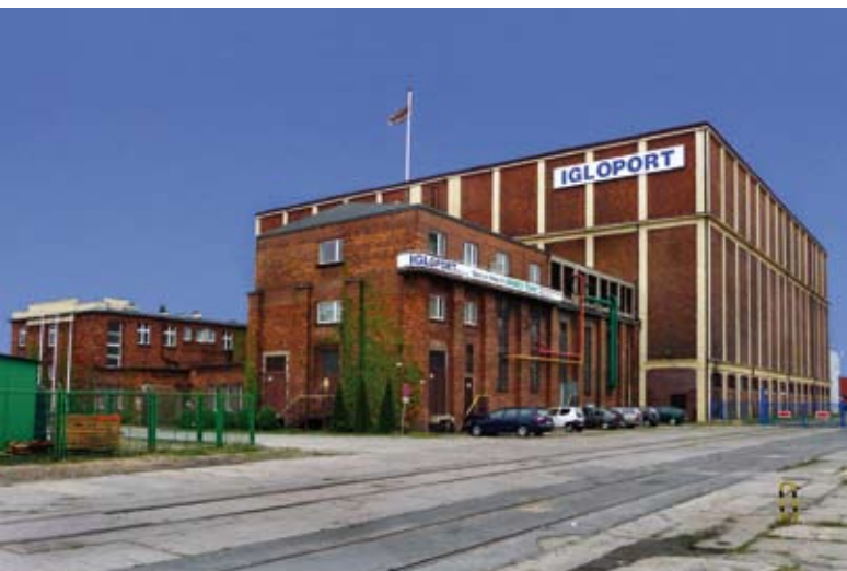
3. Budynek chłodni w porcie Gdynia, stan 2009. Fot. T. Błyskosz.
