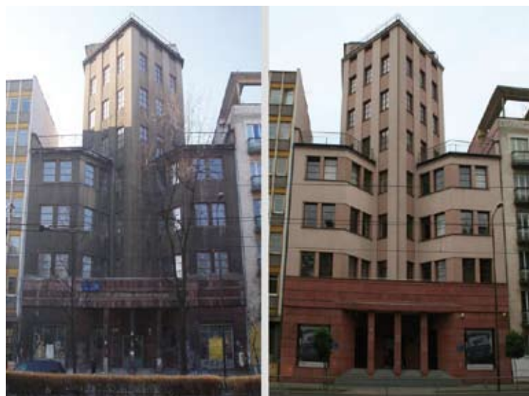
3. Gmach Powszechnego Zakładu Ubezpieczeń Wzajemnych w Łodzi, arch. Waclaw Rytteł 1929 r. fot. autorzy 2003, 2009.
