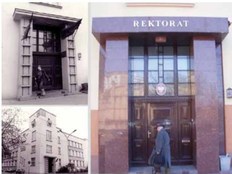
2. Wydział Kanalizacji i Wodociągów Magistratu m. Łodzi, arch. Wiesław Lisowski (1927) 1928 r. Fot. autorzy 1985, 2009.
