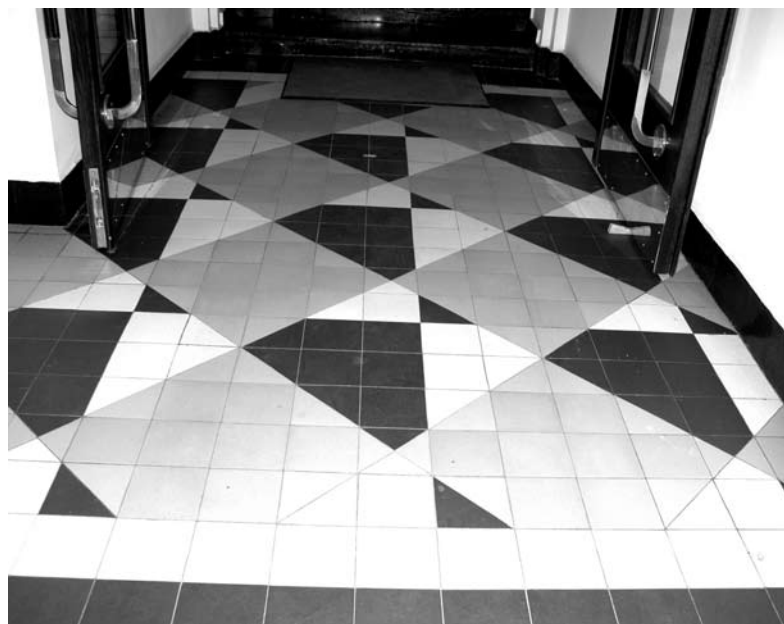
3. Siedziba Zarządu Morskiego Portu Gdynia S. A. (dawny Urząd Celny w Gdyni, arch. Stanisław Odyniec-Dobrowolski, 1934-36 r.) – fragment zachowanej posadzki mozaikowej westybulu (trójbarwna, diagonalna kompozycja geometryczna), fot. A. Orchowska-Smolińska
