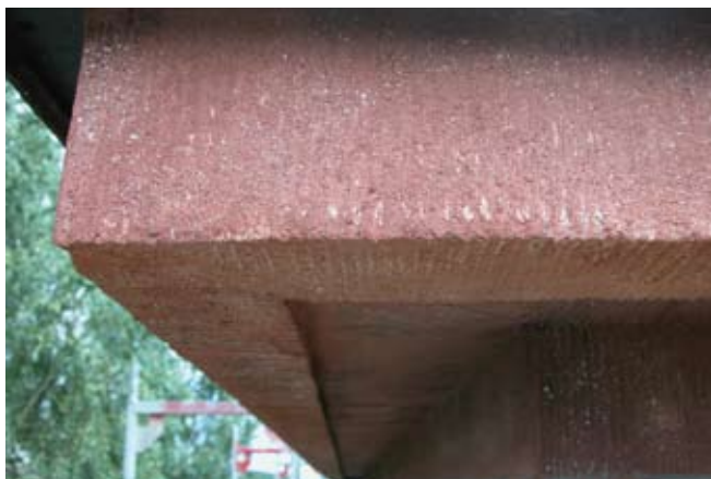
4. Gzyms fasady willi przy ul. Inżynierskiej 111, (arch. N. Obrycki, 1936-1937): przykład barwionego w masie „sztucznego kamienia” z domieszką białego, marmurowego tłucznia. Fot. I. Huk-Malinowska
