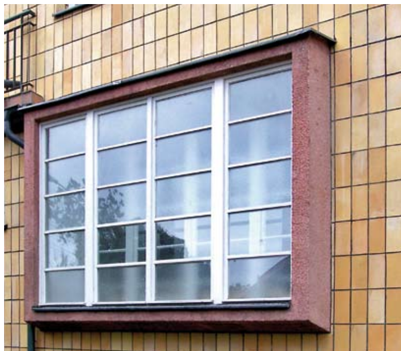
5. Fragment elewacji bocznej willi przy ul. Inżynierskiej 111. Na końcowy efekt współgrających rytmicznych podziałów elewacji i okna składają się starannie dobrane materiały: układ płytek podkreślają barwione na czarno spoiny, witrynowe okno ujęte zostało w masywną ramę z fakturowego, czerwonego lastryka z miką, balkon ogranicza balustrada z rurek w kolorze spoin. Fot. A. Kriegseisen
