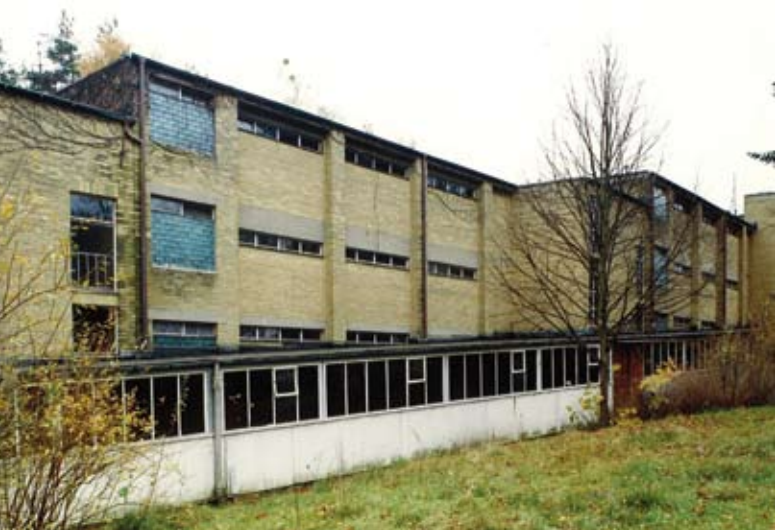
4. Domy studenckie z przeszklonym korytarzem przed renowacją (1998), fot. BRENNE Gesellschaft von Architekten mbH, Berlin
