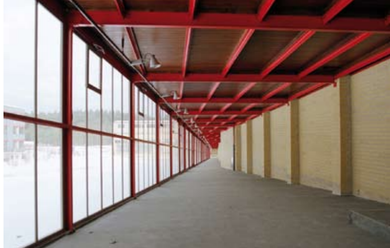
7. Przeszkłony korytarz po renowacji (2007), fot. BRENNE Gesellschaft von Architekten mbH, Berlin
