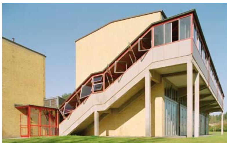
9. Budynek szkolny po renowacji (2007), fot. BRENNE Gesellschaft von Architekten mbH, Berlin
