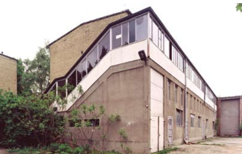
8. Budynek szkolny przed renowacją (1998), fot. BRENNE Gesellschaft von Architekten mbH, Berlin
