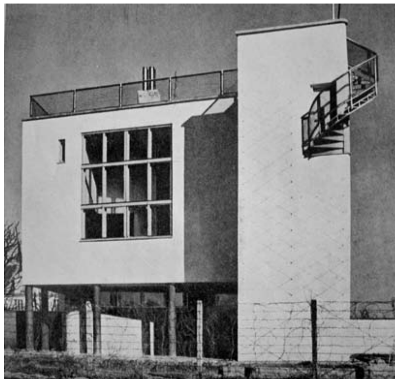
2. Dom mieszkalny przy ul. Katowickiej 9-11-11a w Warszawie, proj. Bohdan Lachert, Józef Szanajca, 1928-1929, rep. wg: Hanna Faryna-Paszkiwicz, Saska Kępa 1918-1939. Architektura i Urbanistyka, Wrocław - Warszawa - Kraków - Gdynia - Łódź 1989, il. 16
