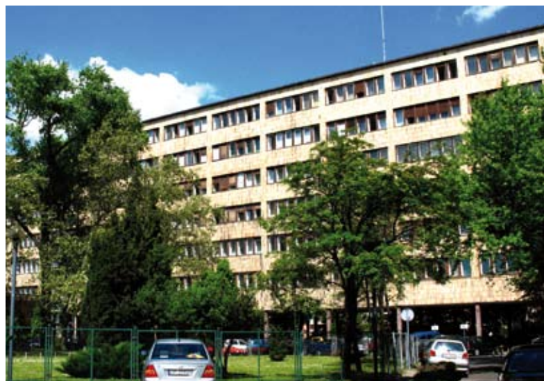
4. Budynek „nowej” rejencji w Opolu (ob. Urząd Wojewódzki), ul. Piastowska 14, proj. Friedrich Lehmann, 1932-36. Fot. E. Kalbarczyk-Klak, 2009.
