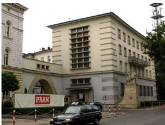
5. Nowa część budynku pocztowego, ul. Korfantego 1 w Opolu, ok. 1932. Fot. E. Kalbarczyk-Klak, 2009.
