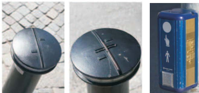
Ryc. 5.8. Schematy dotykowe przejścia dla pieszych mogą ułatwić wytyczenie kierunku przechodzenia przez jezdnię. Schematy przejść: a) bez wysepki, b,c) z wydzieloną wysepką. (zdj. M. Wysocki)
