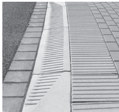
Ryc. 5.4. Specjalne karbowane wykończenie obniżenia krawężnika ułatwiające osobom niewidomym odczytanie laską krawędzi chodnika (źródło:www.asmat-grosshandel.com).
