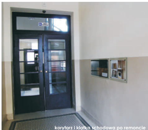
korytarz i klatka schodowa po remoncie
