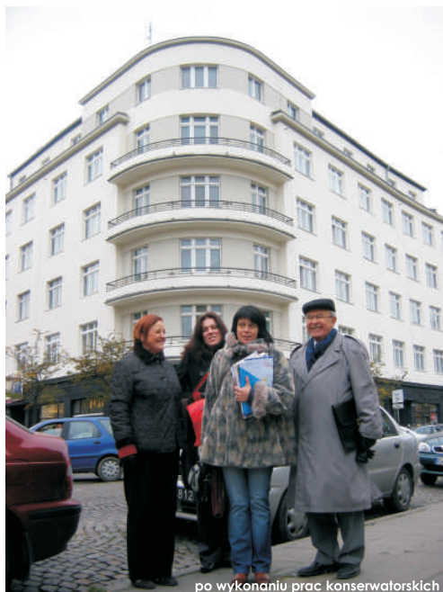
po wykonaniu prac konserwatorskich
