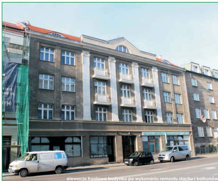
elewacja frontowa budynku po wykonaniu remontu dachu i balkonów
