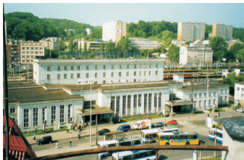
Budynek dworca przed podjęciem kompleksowego remontu.
