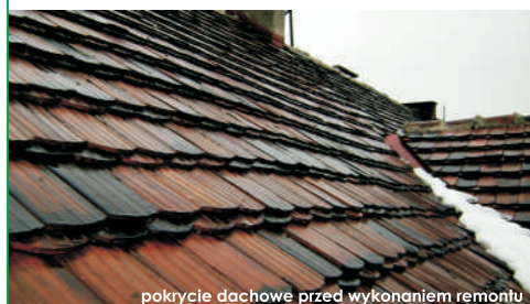
pokrycie dachowe przed wykonaniem remontu
