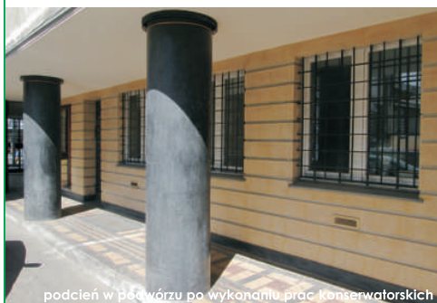
podcień w podwórzu po wykonaniu prac konserwatorskich
