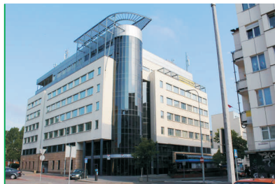
Budynek biurowy „Alfa-Plaza” przy ul. Batorego 28-32 , bud. 1999-2000 proj. Piotr Rutkowski i Zbigniew Młodzianowski, Horus Firma Architektoniczna.
