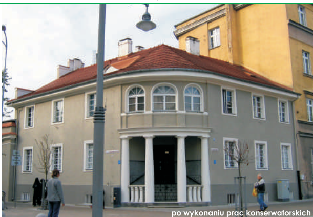
po wykonaniu prac konserwatorskich
