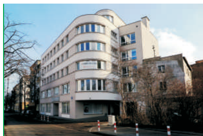
Budynek mieszkalno-usługowy przy ul. Św. Piotra 21 , bud. 2014 r., proj. Jacek Śliwiński, SML Inżynierowie i Architekci.
