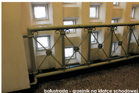
balustrada - grzejnik na klatce schodowej
