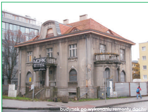
budynek po wykonaniu remontu dachu
