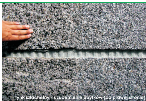
tynk szlachetny - uzupełnienie ubytków (po prawej stronie)
