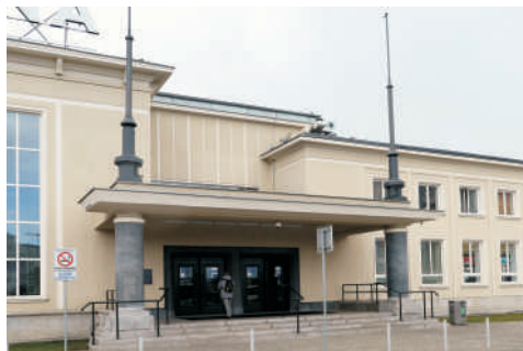
Wejście do budynku dworca głównego po odrestaurowaniu.
