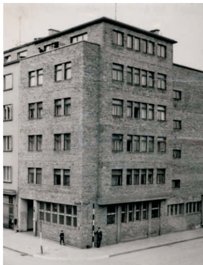
Wybuch wojny przerwał roboty budowlane przy wielu budynkach.
