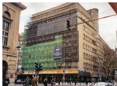
w trakcie prac przy elewacji
