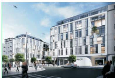
Zespół budynków mieszkalno-usługowych „Bałtyk Plaza” przy ul. Świętojańskiej 43-45 , bud. 2014-15, proj. Jerzy Wolski, Wolski Architekci.
