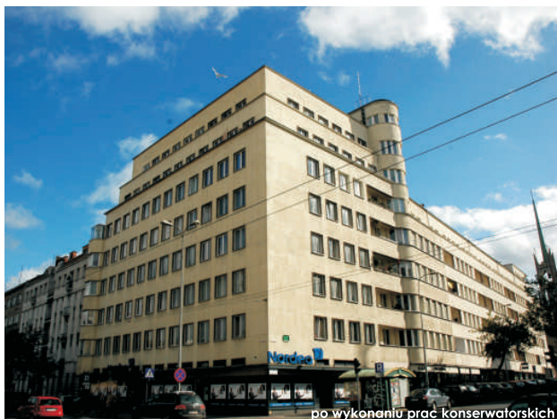
po wykonaniu prac konserwatorskich
