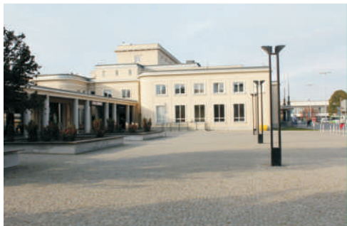
Budynek dworca głównego i pasaż kolumnowy po wykonaniu remontu.
