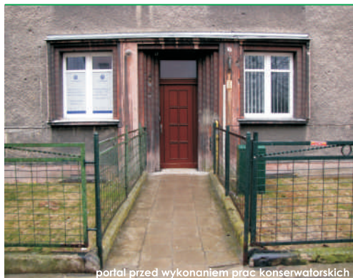
portal przed wykonaniem prac konserwatorskich
