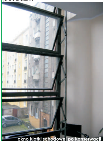
okno klatki schodowej po konserwacji
