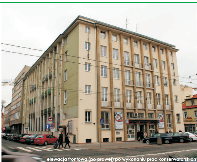
elewacja frontowa (po prawej) po wykonaniu prac konserwatorskich
