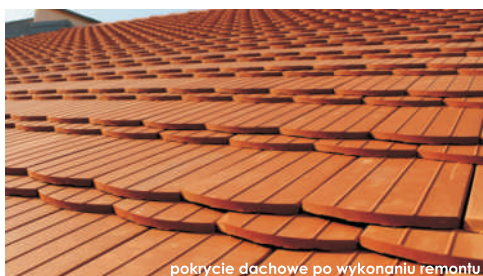
pokrycie dachowe po wykonaniu remontu
