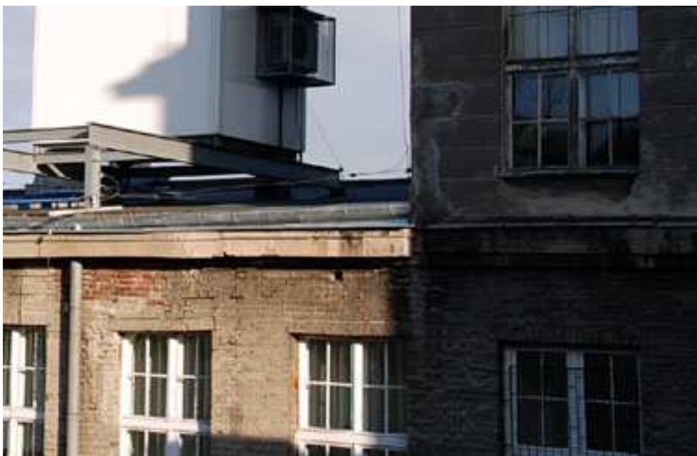
Foto 42 Stan zachowania; strefa gzymsu koronacyjnego przechodzącego w gzyms międzykondygnacyjny; bardzo zły stan techniczny tynków, okładziny ceglanej, gzymsów; na drugim planie widoczny kontener stacji telefonii cyfrowej (elewacja tylna, skrzydło północne)
