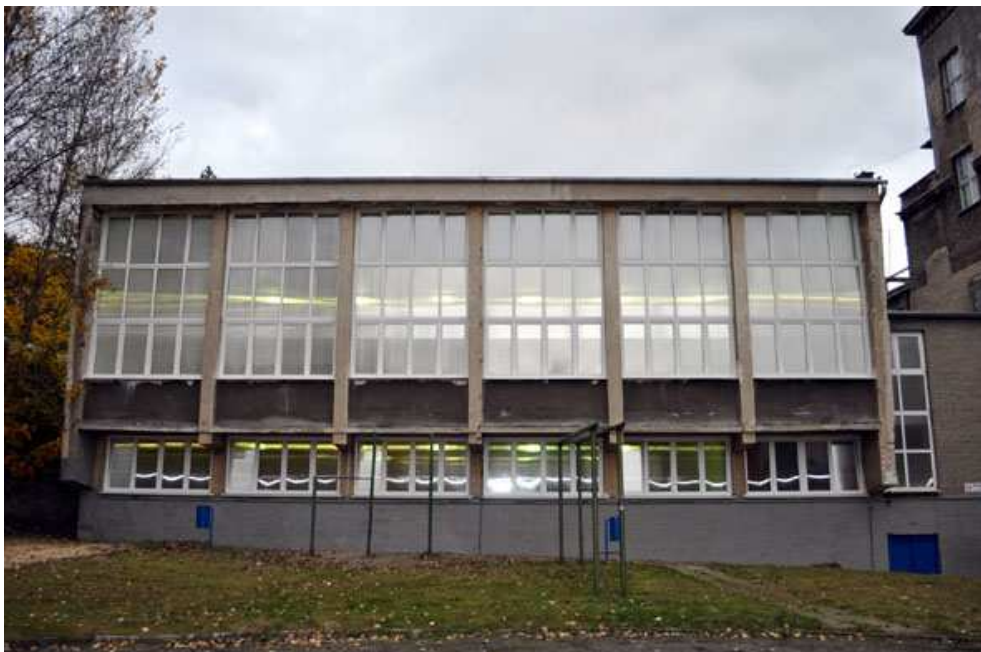
Foto 55 Stan zachowania; budynek szkolnej hali sportowej, elewacja południowo-wschodnia
