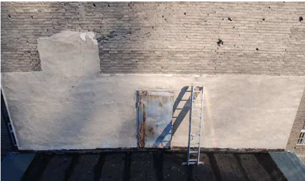
Foto 12 Elewacja tylna, południowo-zachodnia, widok na ścianę szczytową ryzalitu w dolnej części i na dach łącznika
