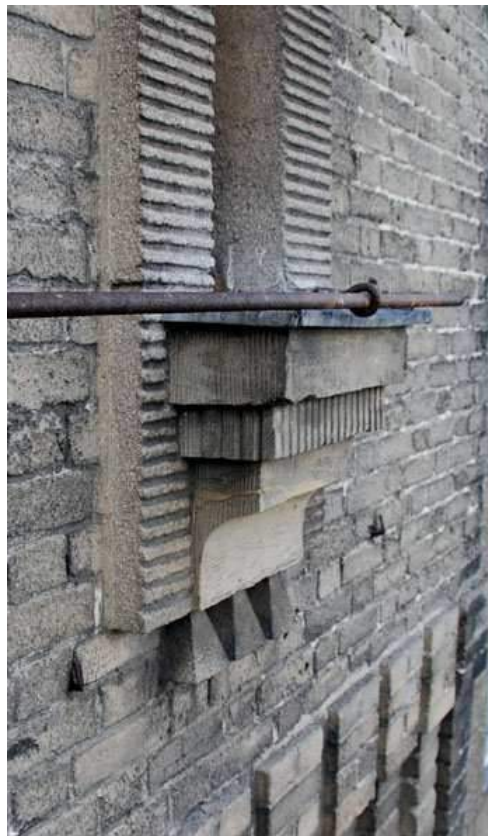
Foto 21, 22 Detal architektoniczny górnej części ryzalitu frontowego; po lewej konsolki podtrzymujące gzyms, po prawej konsolki okienek szczelinowych
