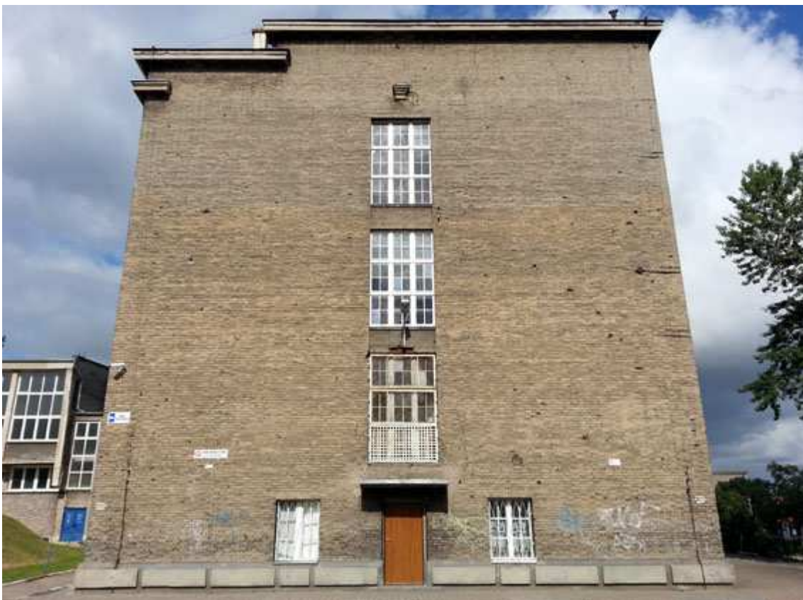
Foto 4 Elewacja boczna, południowo-wschodnia, gmach główny z widocznym wejściem bocznym do budynku i osiowo rozstawionymi oknami
