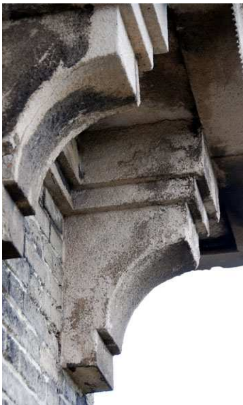
Foto 21, 22 Detal architektoniczny górnej części ryzalitu frontowego; po lewej konsolki podtrzymujące gzyms, po prawej konsolki okienek szczelinowych
