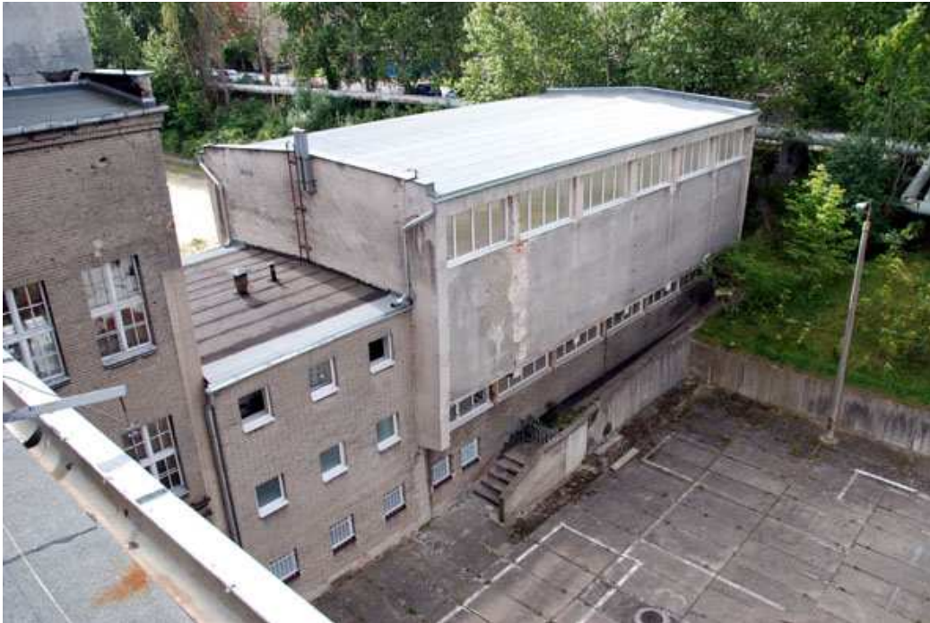
Foto 15 Budynek szkolnej hali sportowej wraz z łącznikiem, widok na elewację północno-zachodnią
