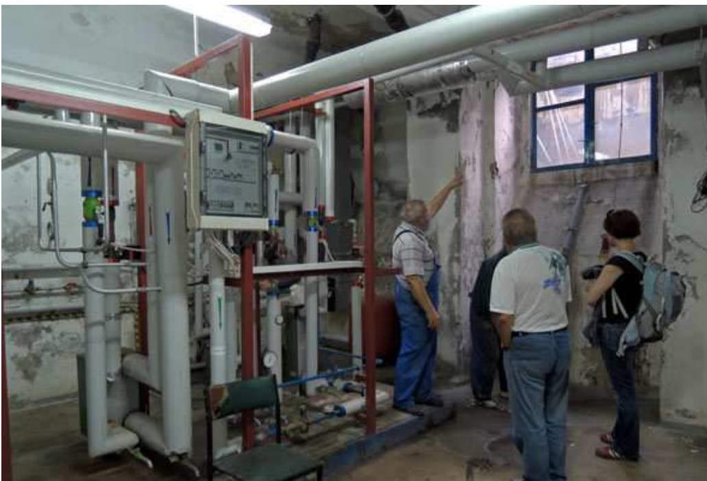
Foto 62 Stan zachowania; kondygnacja podziemna, widoczne silne zawilgocenia ścian wewnętrznych, ubytki, zagrzybienia, wysolenia
