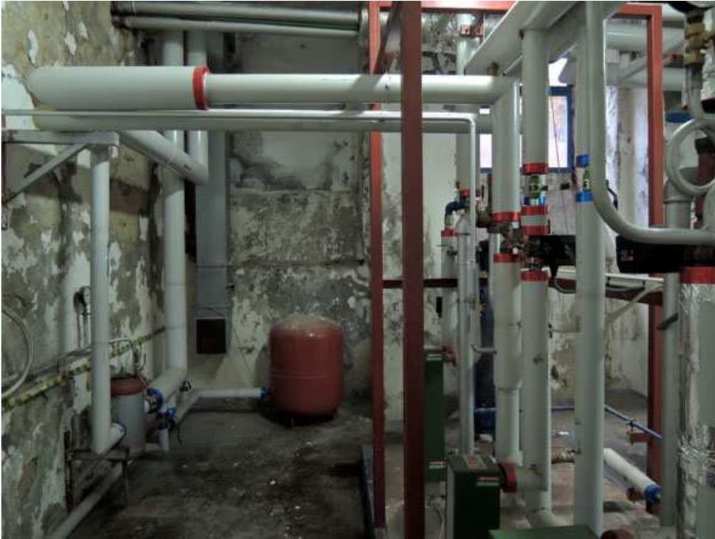
Foto 61 Stan zachowania; kondygnacja podziemna, widoczne silne zawilgocenia ścian wewnętrznych, ubytki, zagrzybienia, wysolenia
