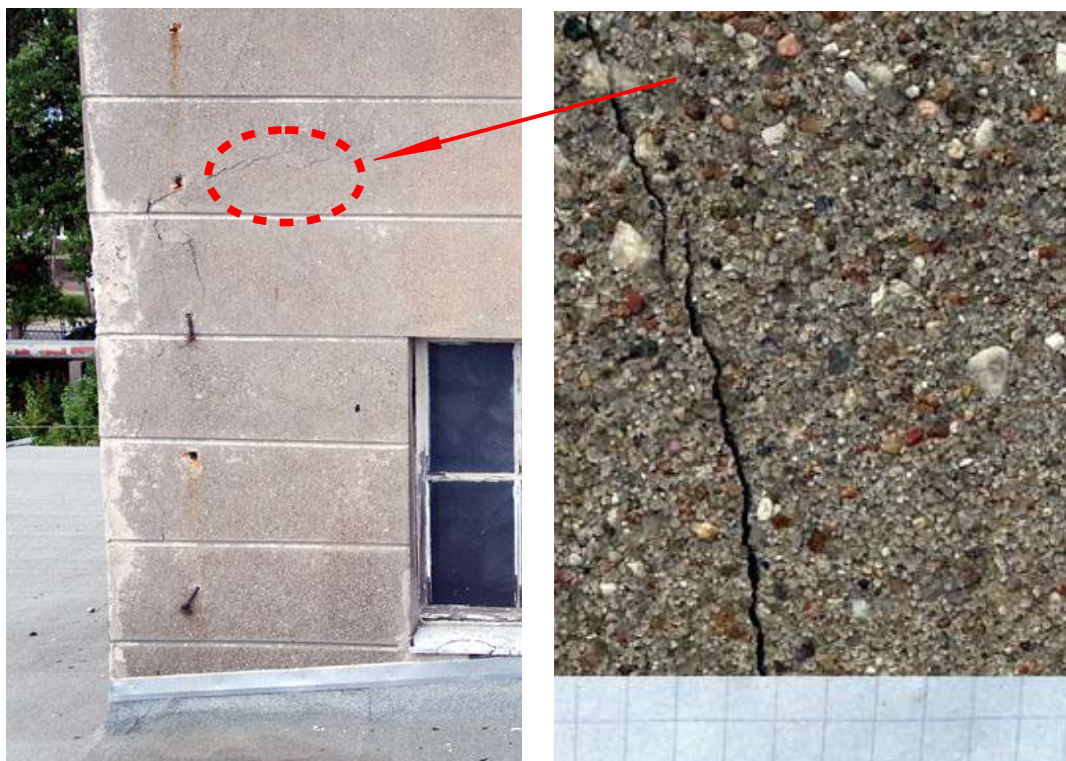
Ilustracja 3, 4 tynk elewacyjny belwederku; na zdjęciu widoczna struktura powierzchni tynku
