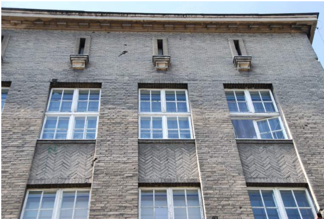
Foto 33 Detal architektoniczny; dekoracja elewacji frontowej
