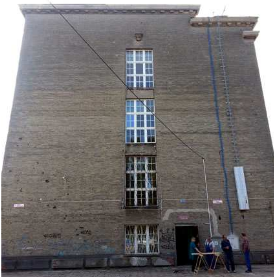
Foto 6 Elewacja boczna północno-zachodnia; widok na elewacje gmachu głównego
