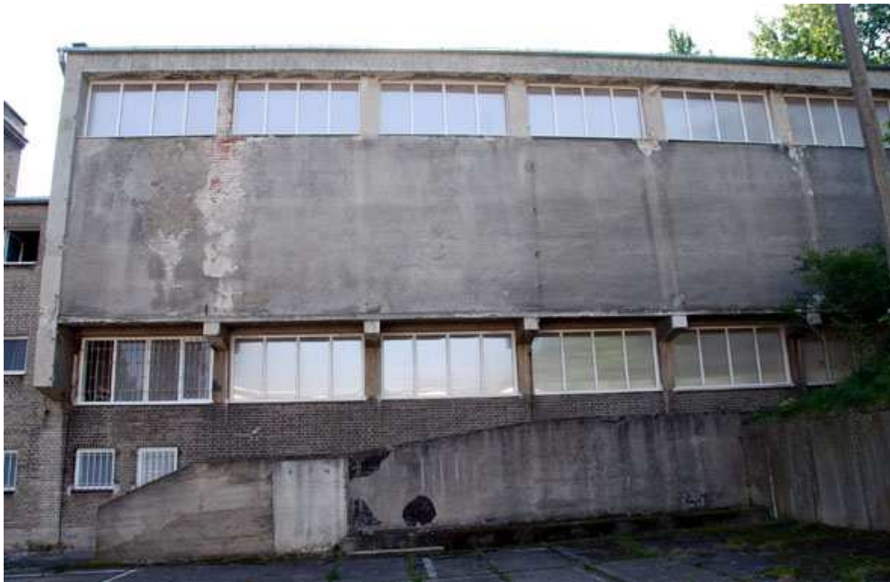
Foto 54 Stan zachowania; budynek szkolnej hali sportowej, elewacja północno-zachodnia, widoczne zniszczenia elewacji, na pierwszym planie betonowy mur oporowy
