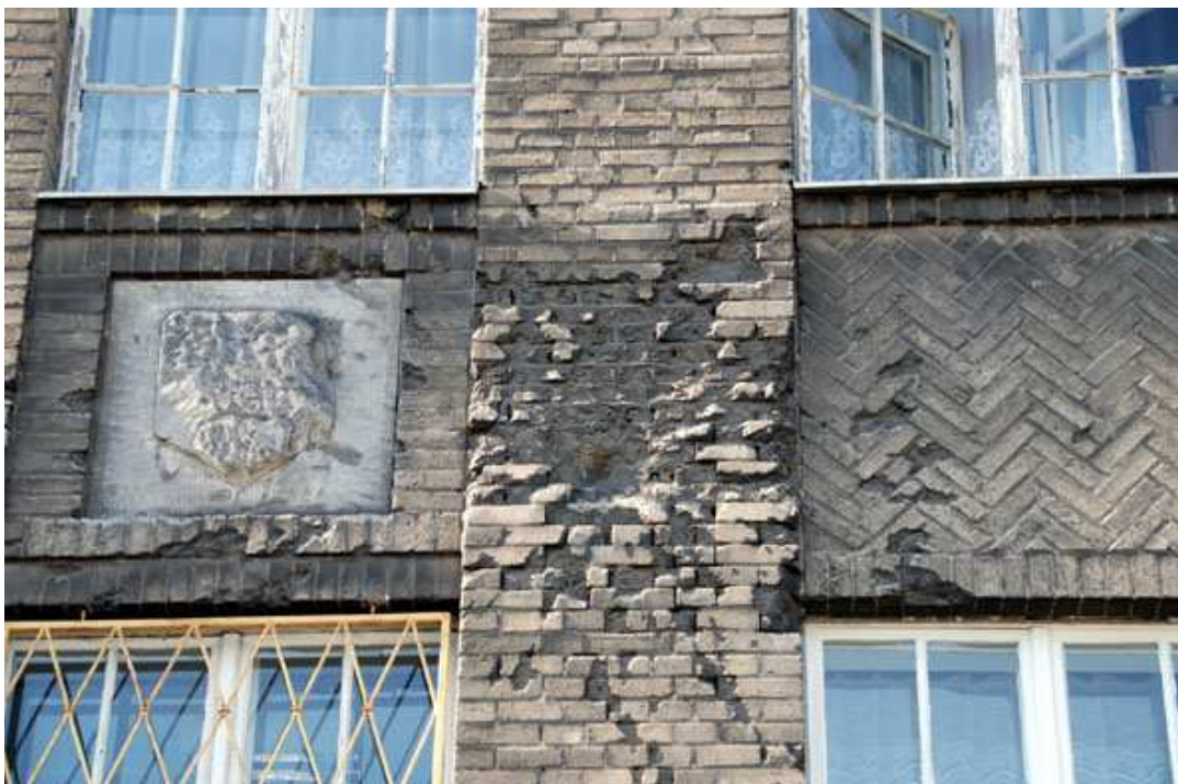
Foto 40 Stan zachowania; ubytki w strukturze okładziny z cegły cementowej, elewacja frontowa
