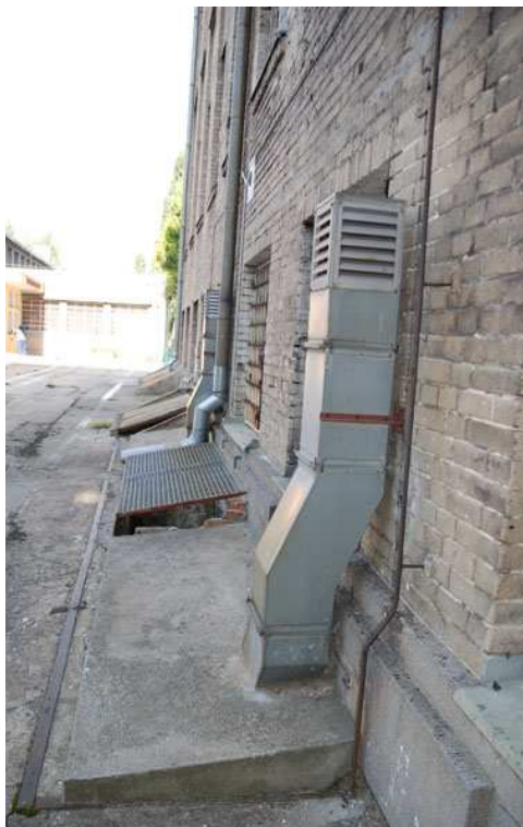
Foto 58, 59 Stan zachowania; po lewej strefa cokołu, elewacja południowo-zachodnia, widoczne zrzuty na węgiel i elementy instalacji wentylacyjnej; po prawej kondygnacja podziemna, widoczne zawilgocenia ścian wewnętrznych
