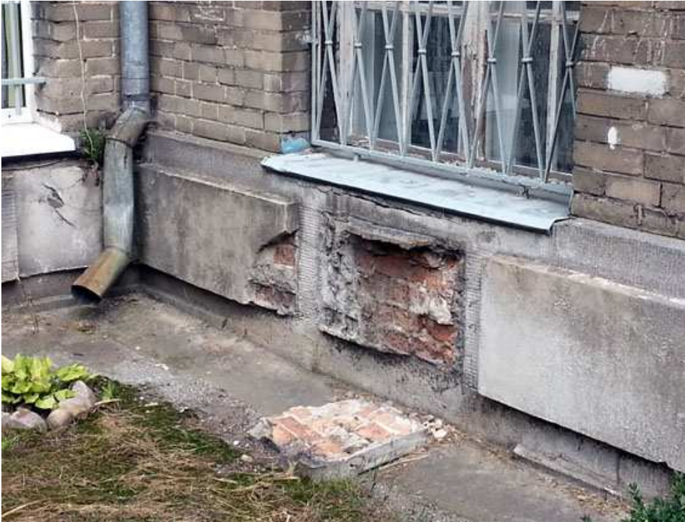
Foto 48 Stan zachowania; strefa cokołu, elewacja południowo-zachodnia
