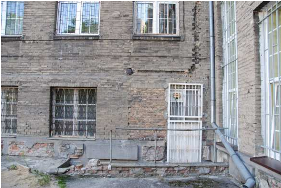
Foto 52 Stan zachowania; strefa cokołu, elewacja południowo-zachodnia; wtórne nieużytkowane wejście do budynku wraz ze schodami, zniszczony cokół, zamurowany otwór pierwotny, uszkodzenia mechaniczne po przeprowadzonej instalacji
