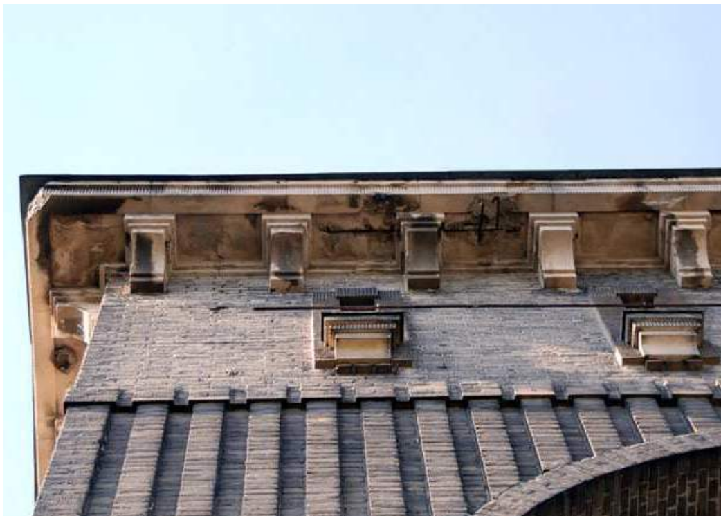
Foto 44 Stan zachowania; strefa gzymsu koronacyjnego na ryzalicie frontowym, widoczne odstąpięte zbrojenie, zacieki, ubytki substancji
