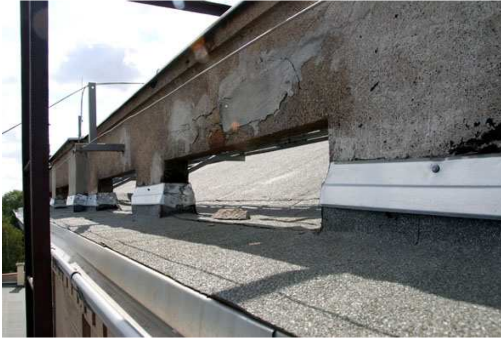
Foto 45 Stan zachowania; strefa attyki belwederku – bardzo zły stan zachowania
