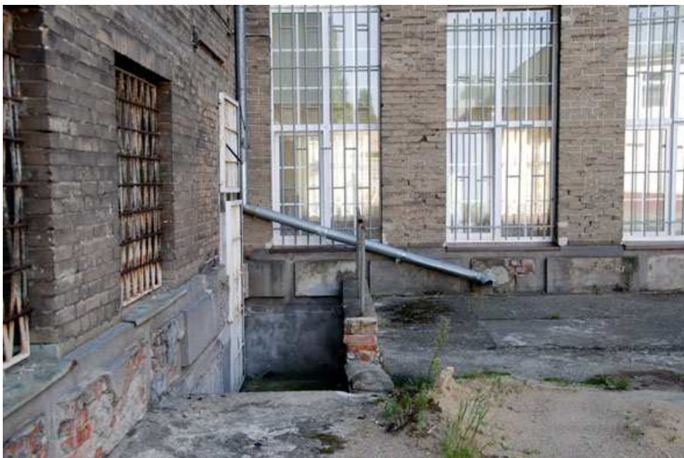
Foto 53 Stan zachowania; strefa cokołu, elewacja północno-zachodnia; wtórne nieużytkowane wejście do budynku wraz ze schodami, zniszczony cokół
