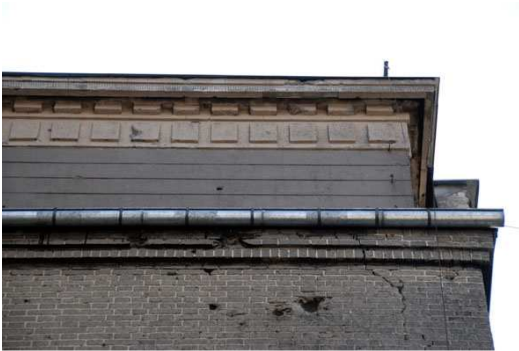
Foto 27 Detal architektoniczny; gzymsy ryzalitu na bryle ryzalitu elewacji tylnej
