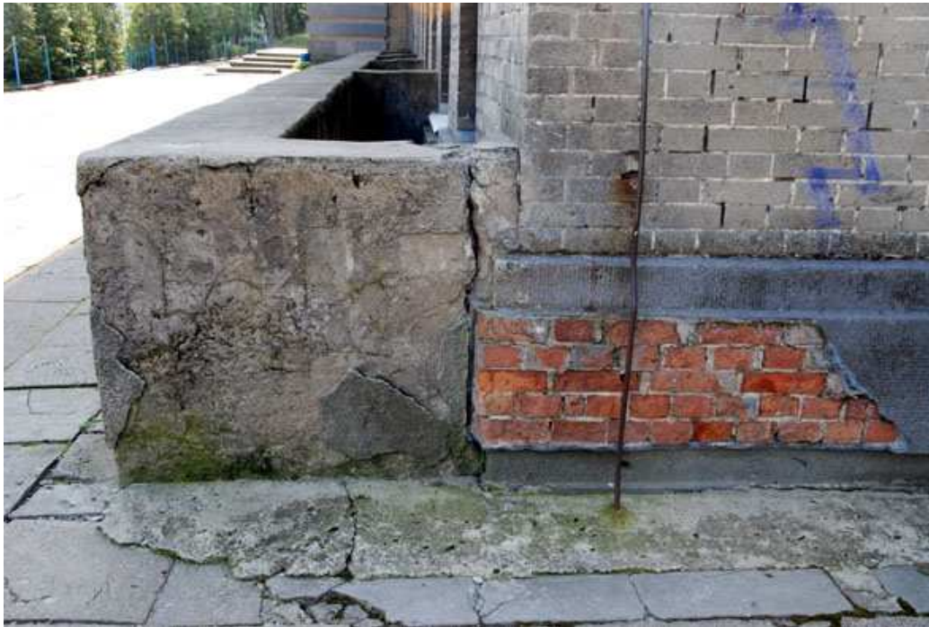
Foto 50 Stan zachowania; strefa cokołu, elewacja północno-zachodnia; miejsce styku dobudowanego betonowego muru i cokołu oryginalnego
