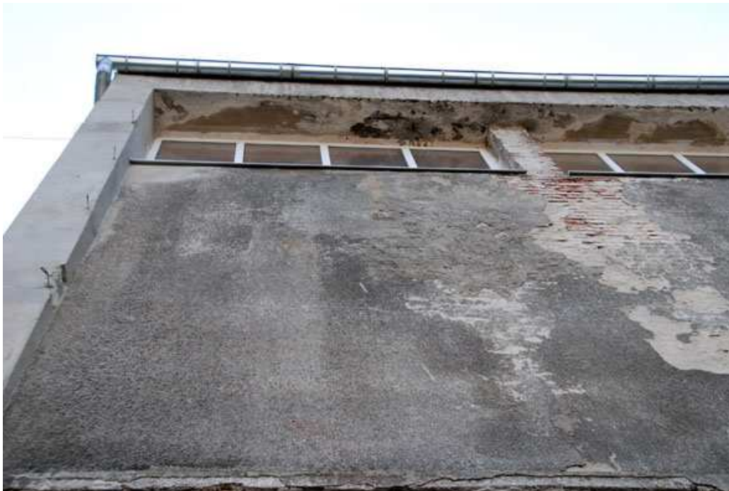
Foto 57 Stan zachowania; budynek szkolnej hali sportowej, elewacja północno-zachodnia, widoczne zniszczenia tynków oraz nadproży
