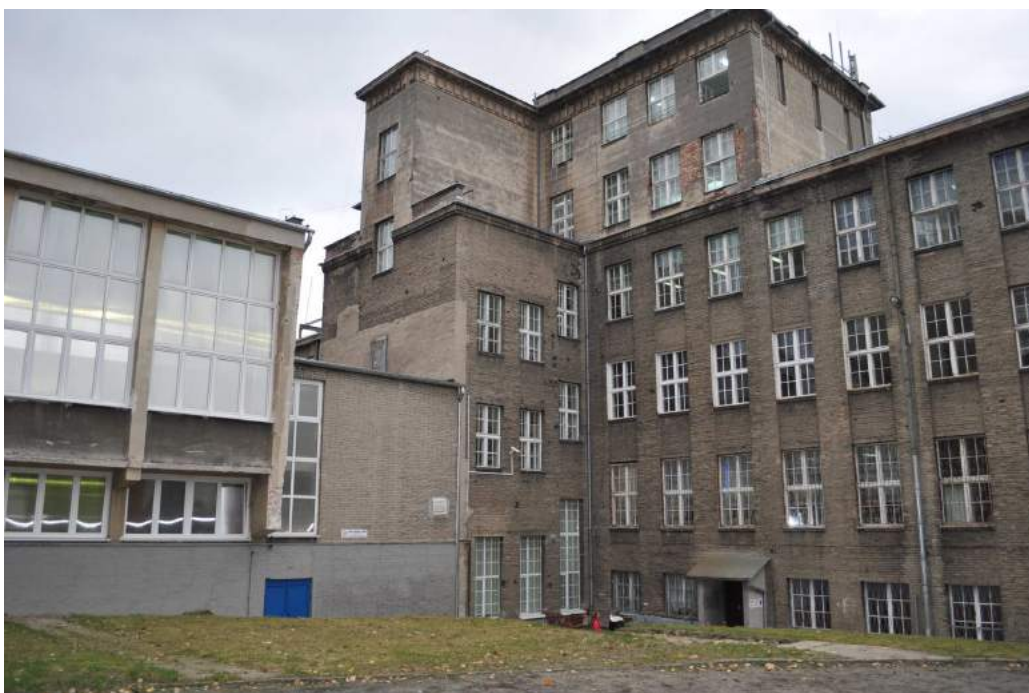
Foto 13 Elewacja południowo-zachodnia (skrzydło południowe) i południowo-wschodnia, widok na część narożnikową budynków wraz z łącznikiem, w górze widoczna bryła nadbudówki
