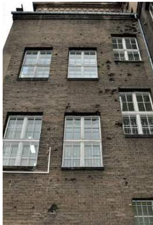
Foto 38, 39 Stan zachowania; rysy, zabrudzenia, ubytki na elewacjach
