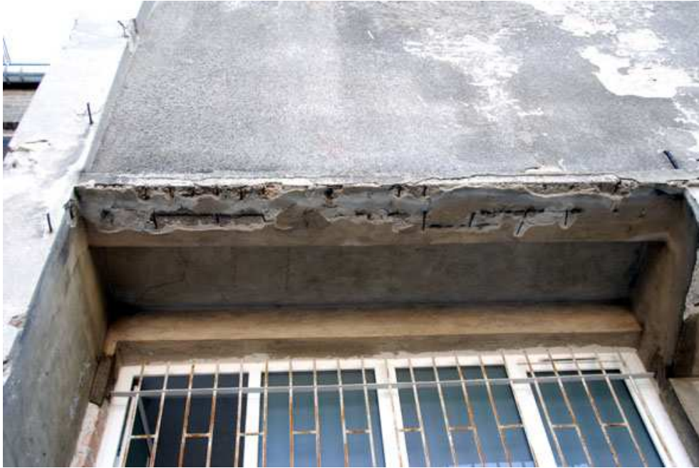
Foto 56 Stan zachowania; budynek szkolnej hali sportowej, elewacja północno-zachodnia, widoczne odkryte zbrojenia
