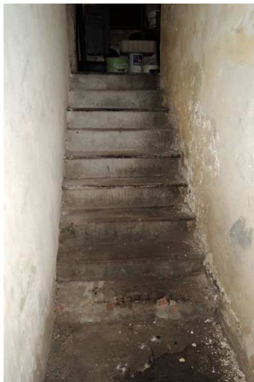
Foto 58, 59 Stan zachowania; po lewej strefa cokołu, elewacja południowo-zachodnia, widoczne zrzuty na węgiel i elementy instalacji wentylacyjnej; po prawej kondygnacja podziemna, widoczne zawilgocenia ścian wewnętrznych
