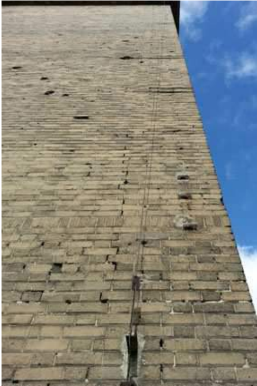
Foto 38, 39 Stan zachowania; rysy, zabrudzenia, ubytki na elewacjach
