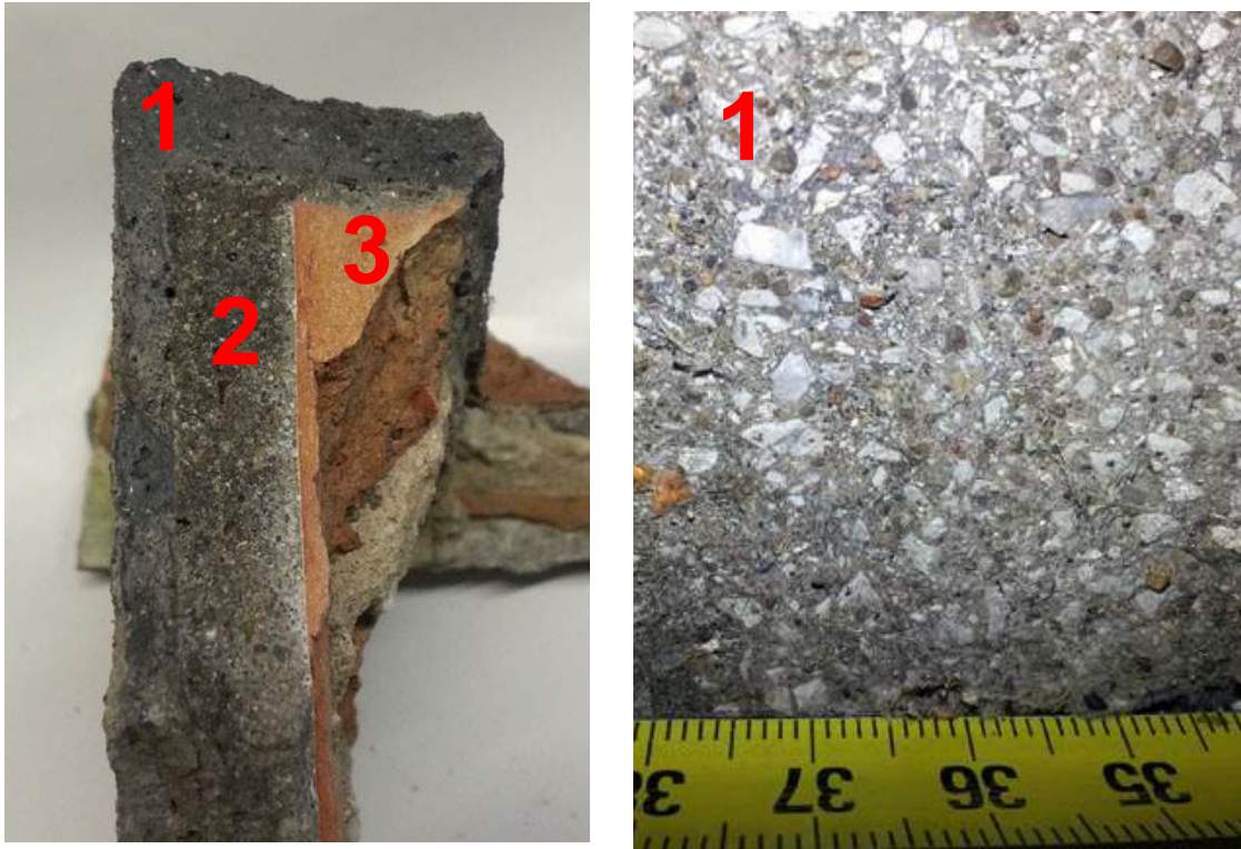
Ilustracja 9, 10 Zaprawa cokołowa: 1 – zaprawa wierzchnia z charakterystycznym białym, „wyplukanym” kruszywem, 2- warstwa spodnia o wyraźnie luźniejszej strukturze (warstwa podkładowa), 3 – warstwa nośna w postaci cegieł ceramicznych
