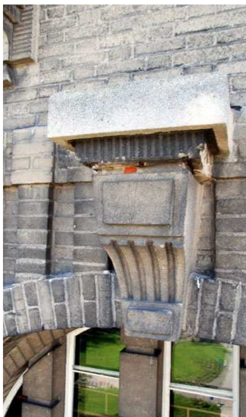
Foto 23, 24 Detal architektoniczny górnej części ryzalitu frontowego; po lewej okienko szczelinowe, po prawej zwornik arkady
