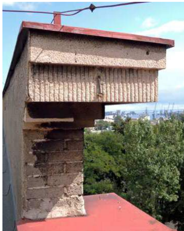
Foto 29, 30 Detal architektoniczny; po lewej profil gzymsu na bryle ryzalitu tylnego; po prawej front gzymsu elewacji południowo-wschodniej
