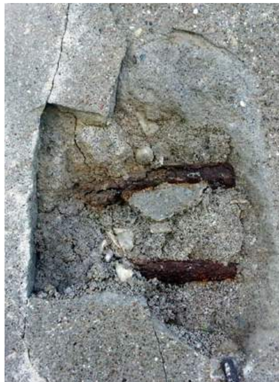
Foto 46, 47 Stan zachowania; zniszczenia substancji budowlanej wywołane korozją zbrojeń; po lewej strefa attyki belwederku, po prawej tynki na ścianie belwederku
