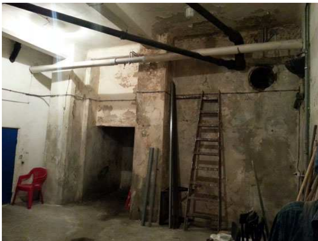
Foto 60 Stan zachowania; kondygnacja podziemna, widoczne silne zawilgocenia ścian wewnętrznych
