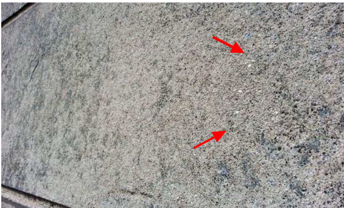
Ilustracja 5 Tynk elewacyjny belwederku, strona pd-wsch; strzałki wskazują widoczne łyszczki (mika) w składzie mieszanki
