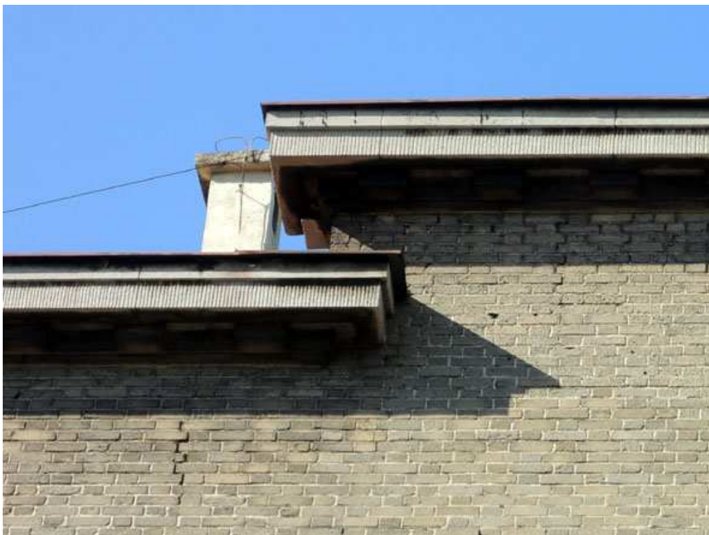
Foto 28 Detal architektoniczny; gzymsy gmachu głównego na elewacji południowo-wschodniej; widoczne rysy w strukturze okładziny
