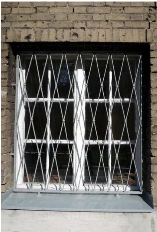
Foto 36, 37 Detal architektoniczny; parter; okna powtarzalne w konstrukcji skrzynkowej (elewacja południowo-zachodnia)
