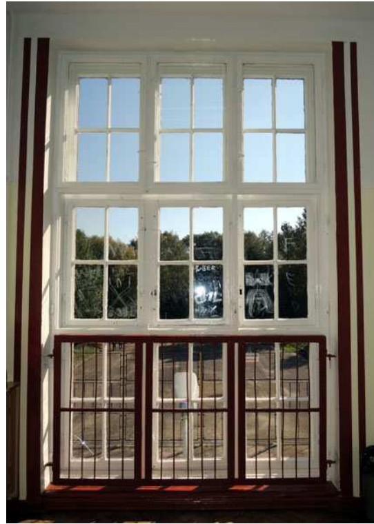
Foto 34, 35 Detal architektoniczny; piętro; okna powtarzalne w konstrukcji skrzynkowej (elewacja południowo-wschodnia)
