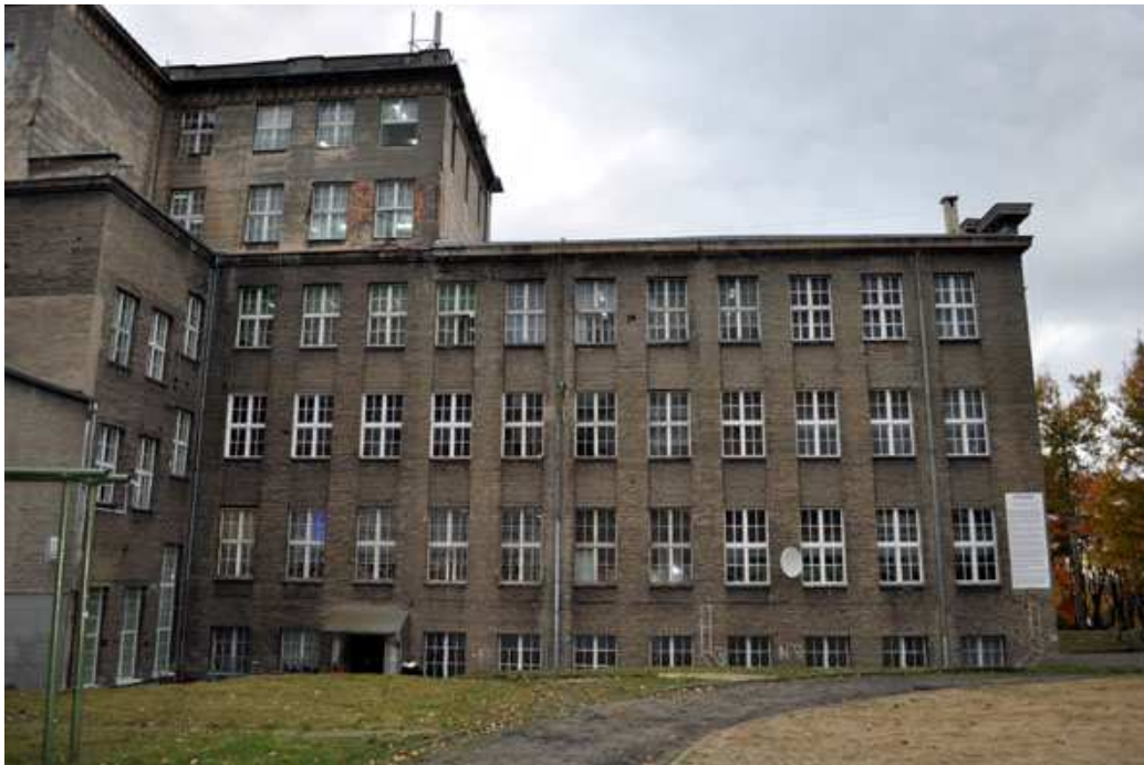
Foto 9 Elewacja tylna, południowo-zachodnia, skrzydło południowe
