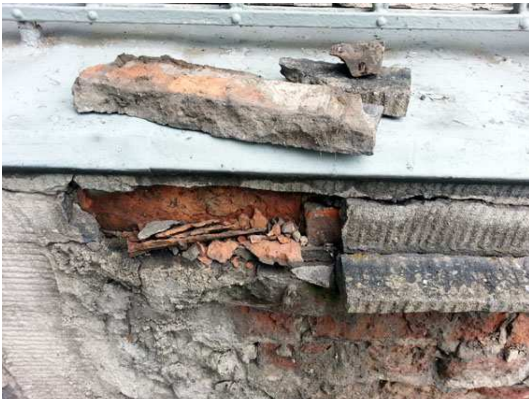
Foto 49 Stan zachowania; strefa cokołu, elewacja południowo-zachodnia; całkowicie zdegradowana podkonstrukcja oraz zaprawa cokołowa
