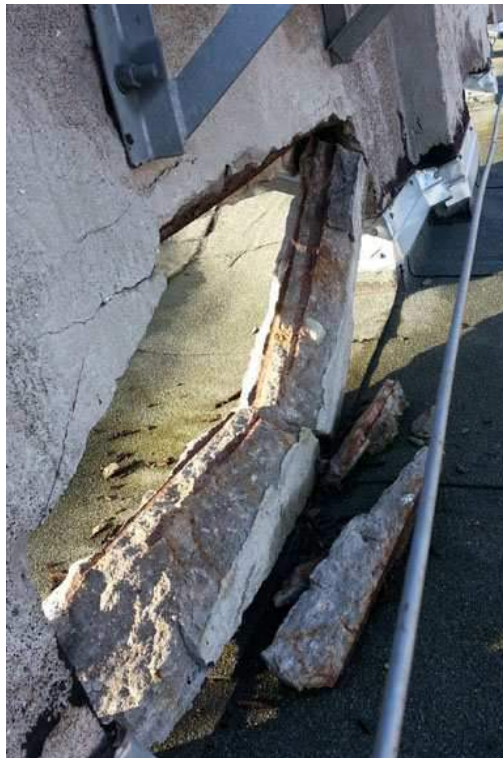
Foto 46, 47 Stan zachowania; zniszczenia substancji budowlanej wywołane korozją zbrojeń; po lewej strefa attyki belwederku, po prawej tynki na ścianie belwederku
