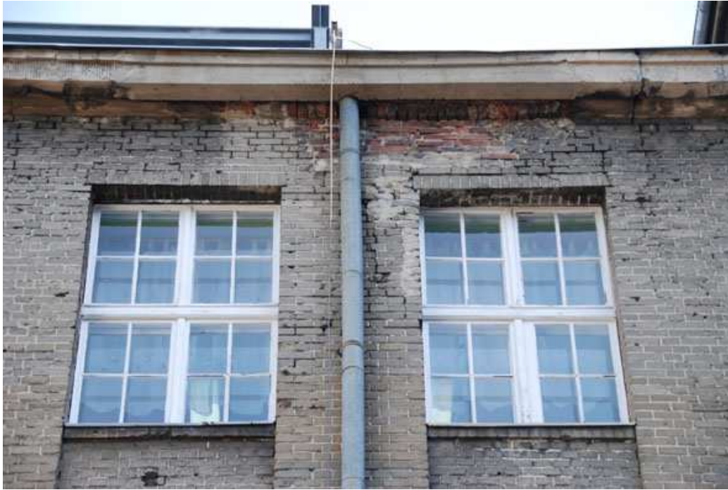
Foto 43 Stan zachowania; strefa gzymsu koronacyjnego, bardzo zły stan techniczny okładziny ceglanej, gzymsu
