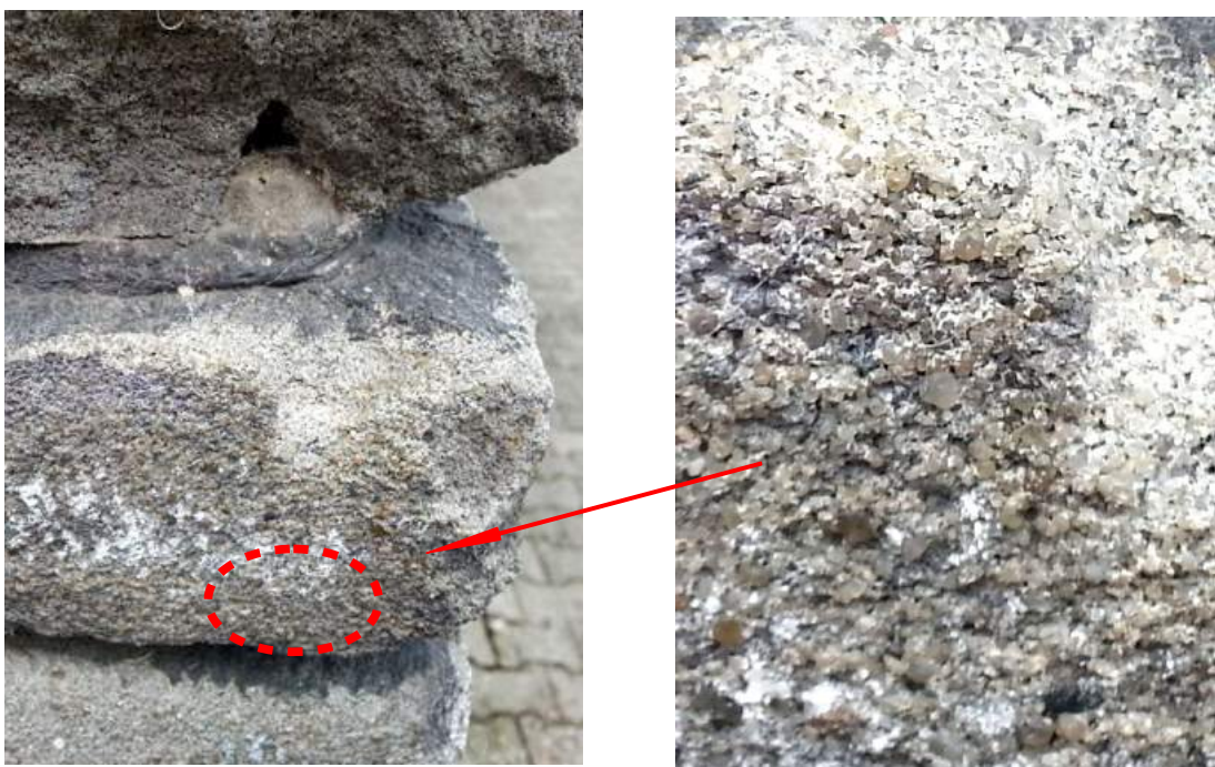
Ilustracja 1, 2 Fragment cegły elewacyjnej z narożnika wschodniego (foto 1) z widoczną strukturą (foto 2); widoczne kruszywo o regularnym uziarnieniu piasku kwarcowego
