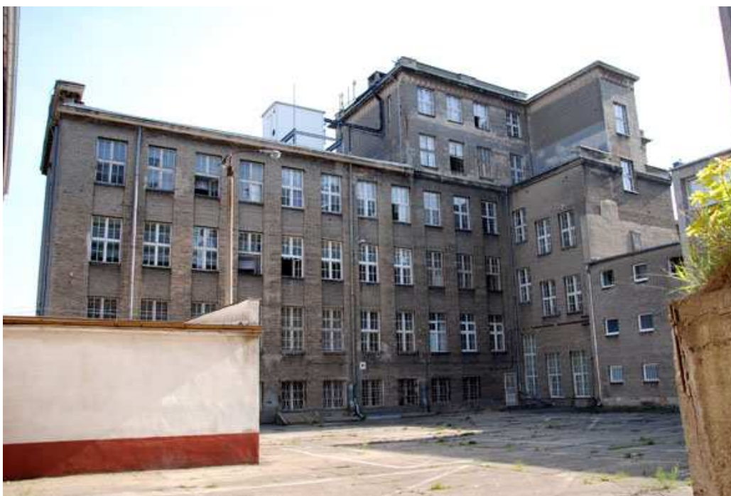
Foto 14 Elewacja południowo-zachodnia (skrzydło północne) i północno-zachodnia, widok na część narożnikową budynków wraz z łącznikiem, w górze widoczna bryła nadbudówki
