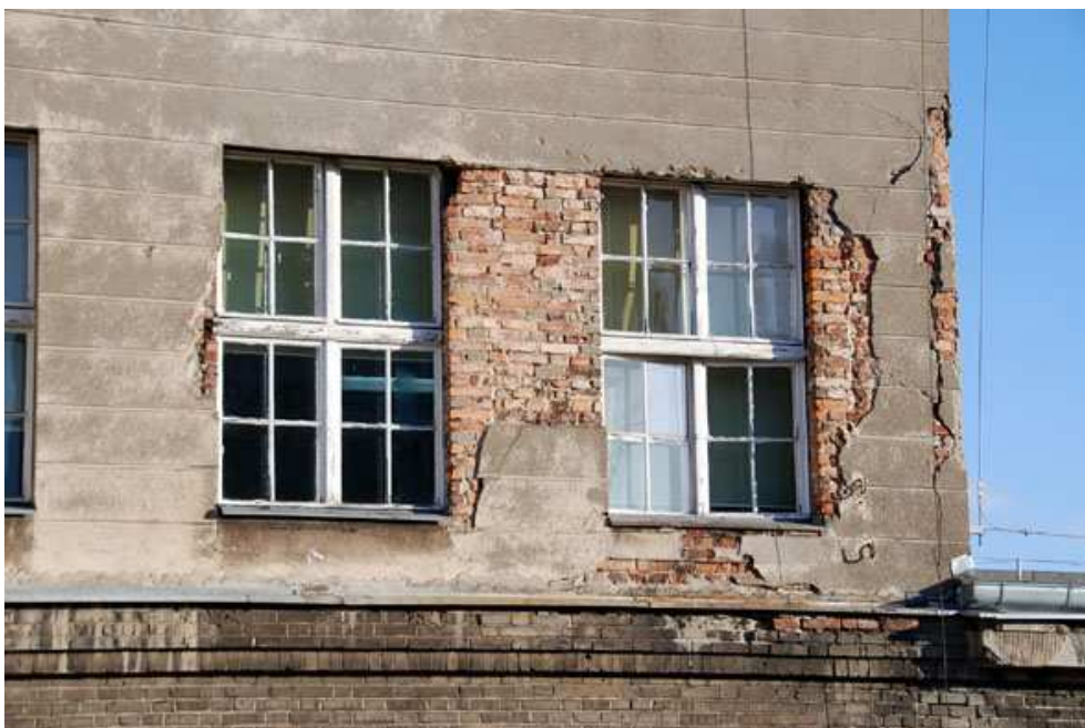
Foto 41 Stan zachowania; ubytki w strukturze okładziny z wyprawy tynkarskiej (belwederek, strona południowo-zachodnia)
