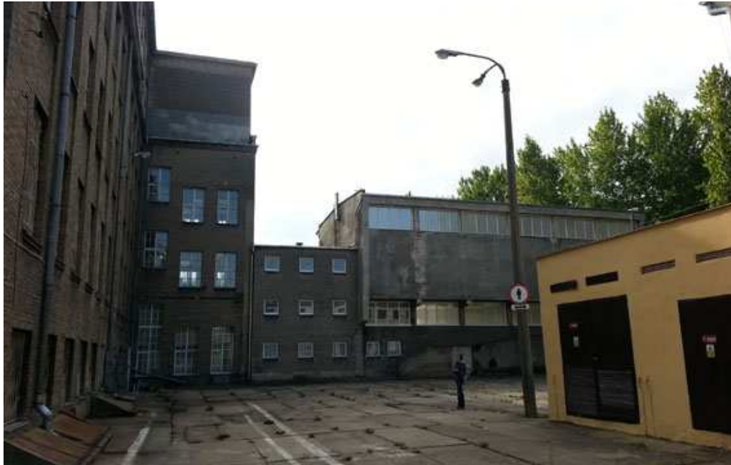
Foto 5 Elewacja boczna północno-zachodnia; widok na ryzalit gmachu głównego, łącznik oraz budynek hali sportowej
