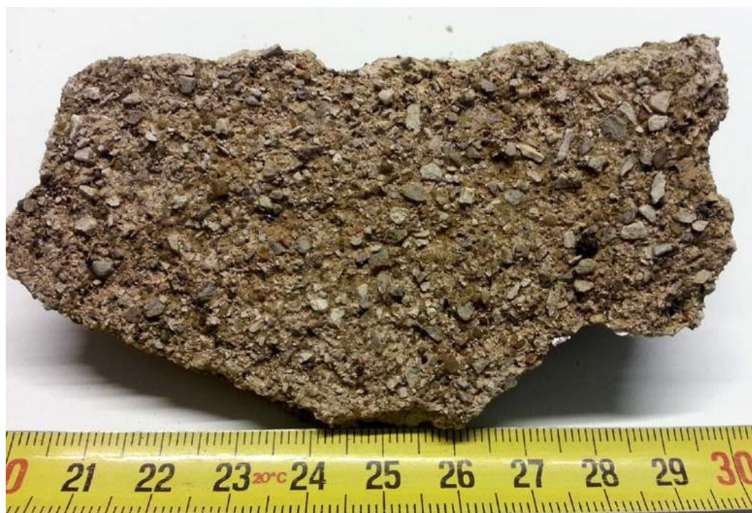
Ilustracja 11 Tynk z gzymsu koronującego belwederku; kruszywo widoczne gołym „okiem”
