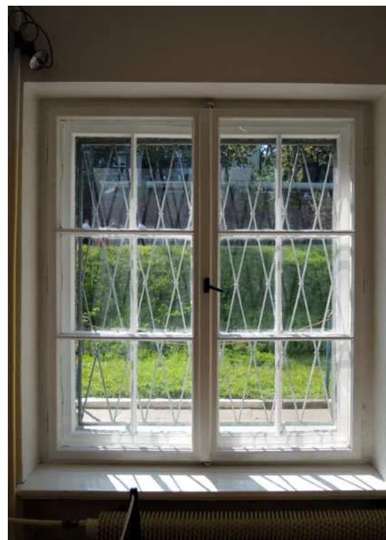
Foto 36, 37 Detal architektoniczny; parter; okna powtarzalne w konstrukcji skrzynkowej (elewacja południowo-zachodnia)
