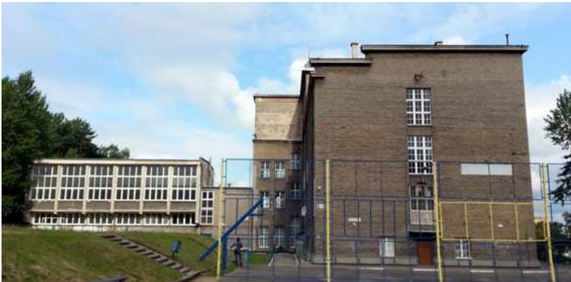
Foto 3, Elewacja boczna, południowo-wschodnia, po prawej gmach główny, po lewej dobudowany budynek szkolnej hali sportowej
