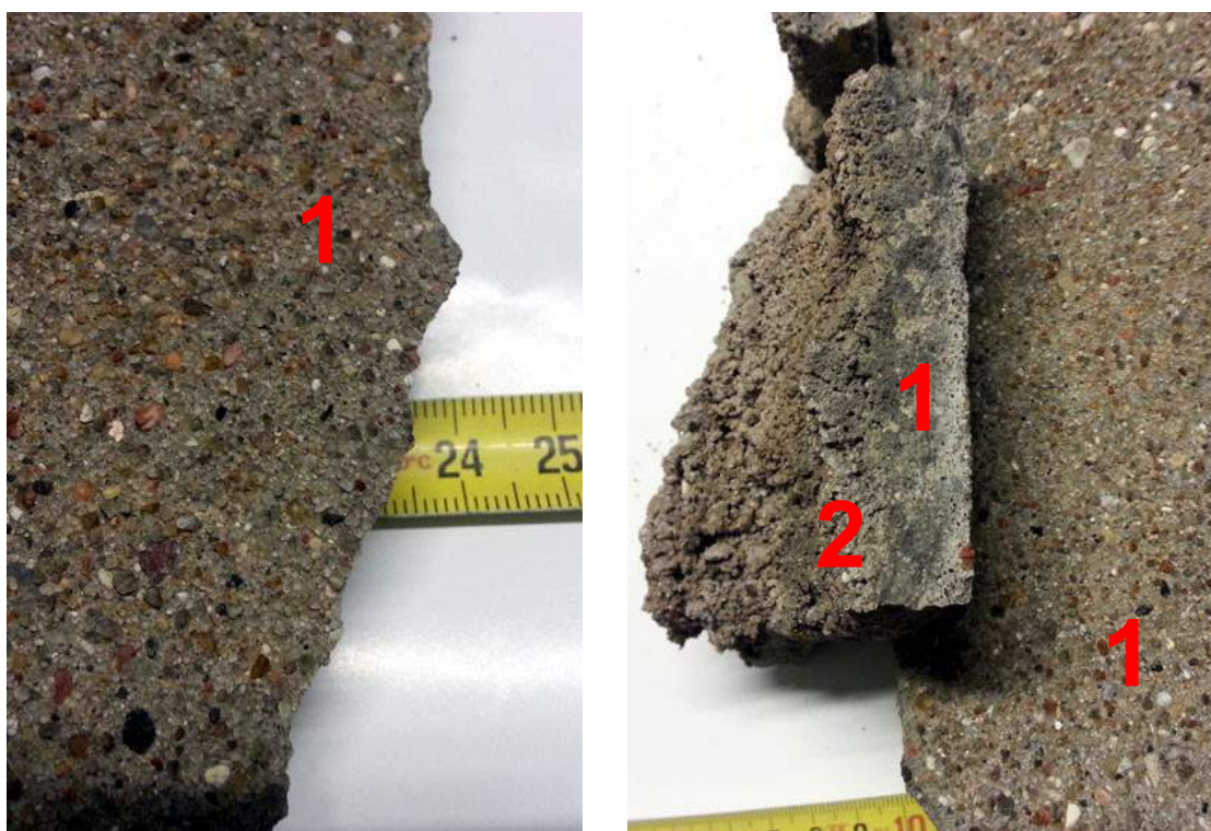
Ilustracja 6, 7 Tynk elewacyjny belwederku, strona pn-wsch; widoczna struktura wewnętrzna zaprawy: 1 – zaprawa wierzchnia z charakterystycznym kolorowym uziarnieniem, 2- warstwa spodnia o wyraźnie luźniejszej strukturze (warstwa podkładowa)
