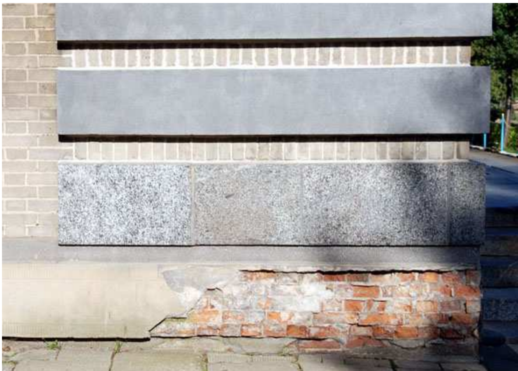
Foto 51 Stan zachowania; strefa cokołu, ryzalit frontowy od strony południowo-wschodniej, widoczne odrestaurowane boniowanie portalu oraz nieodrestaurowany cokół
