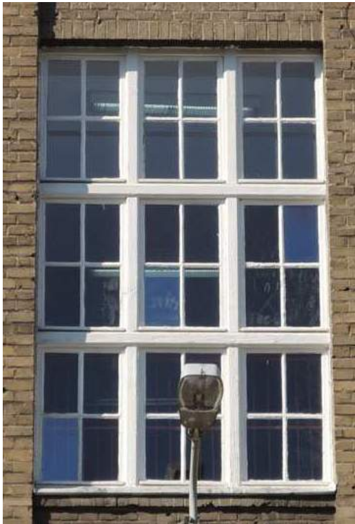
Foto 34, 35 Detal architektoniczny; piętro; okna powtarzalne w konstrukcji skrzynkowej (elewacja południowo-wschodnia)
