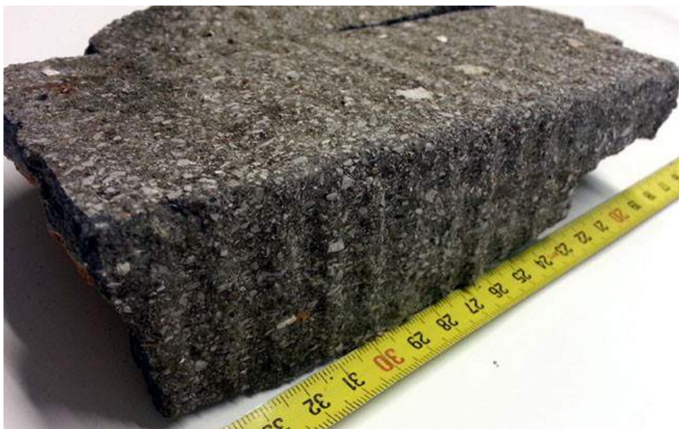
Ilustracja 8 Fragment cokołu z ryzalitu tylnego, elewacja północno-zachodnia; widoczna charakterystyczna struktura powierzchni (lastrykowa)
