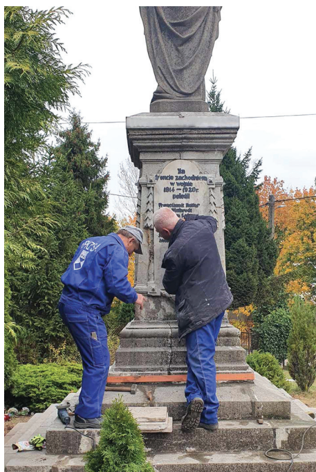
Pomnik w trakcie konserwacji.
