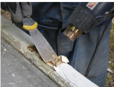
4, 5, 6. Dekoracyjny detal okien d. Zajazdu Adlera przy ul. Orłowskiej 8 w trakcie prac konserwatorskich. Prace konserwatorskie polegały m.in. na usunięciu powłok malarskich poprzez podgrzewanie i zdejmowanie szpachelką grubych warstw farb, następnie uzupełnianie były ubytki w drewnie, elementy były szlifowane, malowane i ponownie szklone. Część zniszczonych elementów trzeba było zrekonstruować, ale okna pochodzą z XIX w. Prace wykonano w ramach kompleksowej rewitalizacji budynku trwającej w latach 2011-2013.
