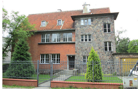
Willa przy ul. Korzeniowskiego z lat 30. XX w. – unikatowy przykład wykończenia elewacji z obrobionych kamieni narzutowych połączonych z licem ceglany
