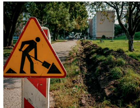
Modernizacja deptaka i remont chodnika w dzielnicy Cisowa (fot. M. Mielewski)
