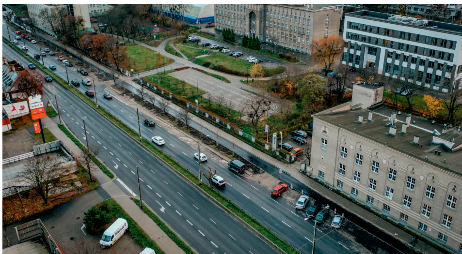
Wyremontowany odcinek trasy pieszo-rowerowej na ul. Morskiej (fot. M. Mielewski)
