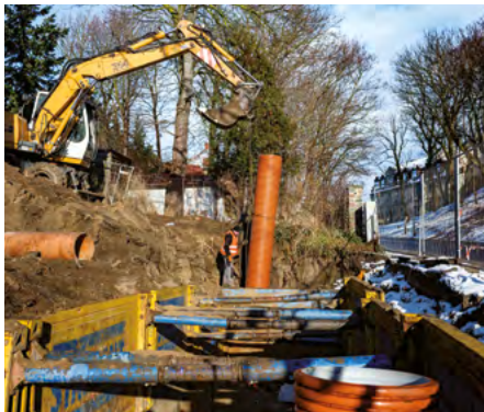
Na Oksywiu górnym trwa przebudowa ul. Makowskiego
