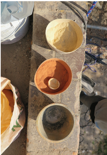
Dobieranie na budowie mieszanek do kitowania dostosowanych kolorami do zróżnicowanej barwy płytek.
