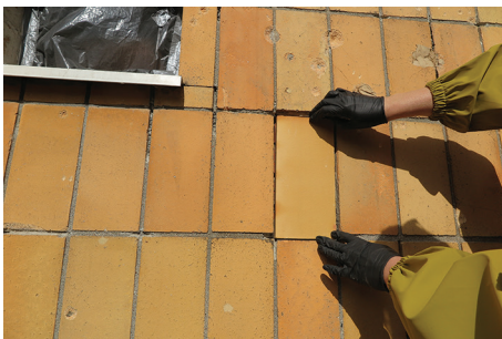
Dopasowywanie nowych płytek w miejsce zniszczonych.
