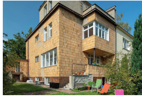
Widok tylnych elewacji budynku przed remontem.
