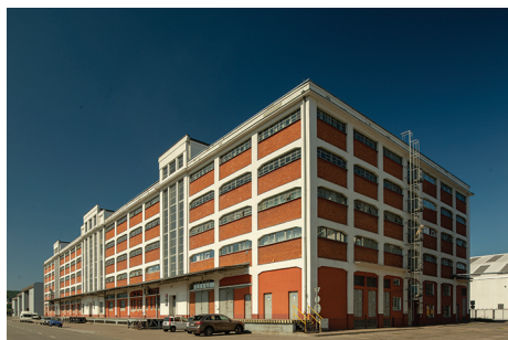
Magazyn długoterminowy H przy ul. Polskiej 17 z konstrukcją żelbetową i wypełnieniem z czerwonych cegieł.
