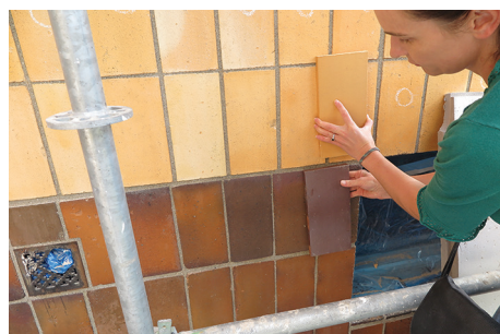
Odspojone oryginalne płytki po zdemontowaniu.
