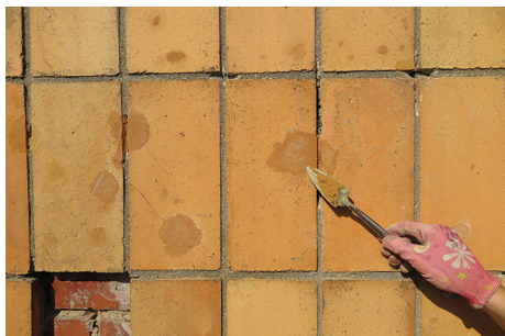
Uzupełnianie ubytków w płytkach na elewacji specjalnymi masami.
