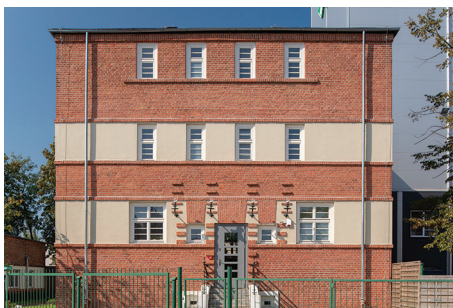
Budynek w Zespole Łuszczeni Ryżu przy Nabrzeżu Indyjskim, kompozycja elewacji z poziomymi pasów wykończonych ceglami i jasnym tynkiem.
