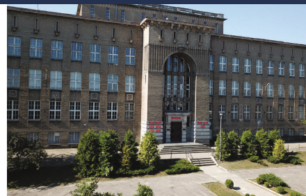
Budynek CKZiU nr 1 w Gdyni // mat. Wyd. Edukacji
