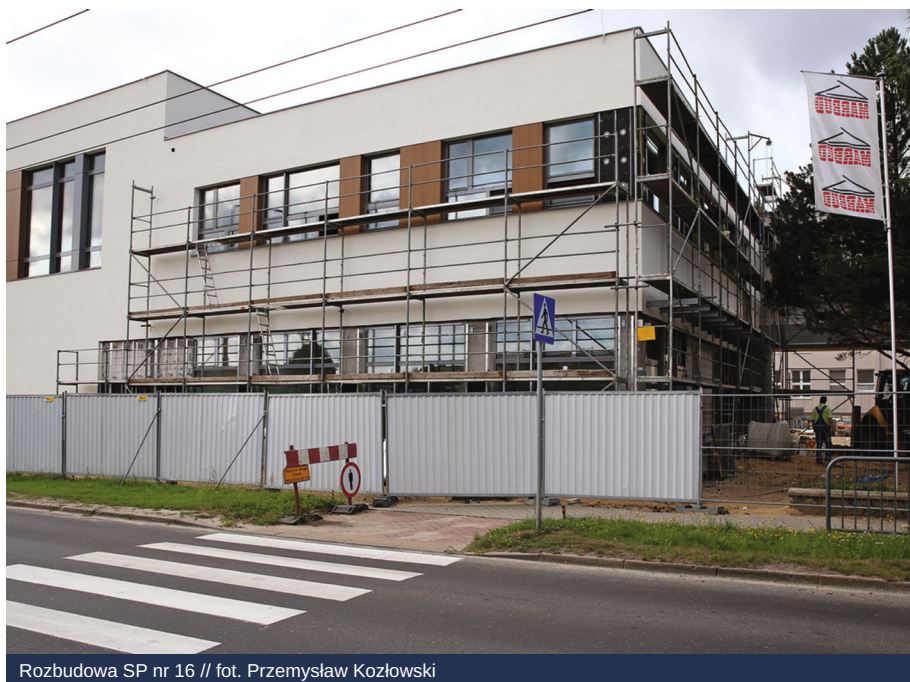
Rozbudowa SP nr 16 // fot. Przemysław Kozłowski
