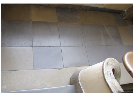
Posadzka na klatce schodowej w budynku przy ul. Abrahama 37. Płyty z wapienia mikrytowego, podstopnice i cokoły schodów z okładziny marmurowej, prawdopodobnie importowanej
