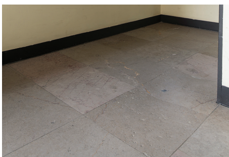
Posadzka w budynku ZUS, ob. Urząd Miasta, przy ul. 10 Lutego 24. Płyty z beżowego i różowego wapienia kieleckiego.
