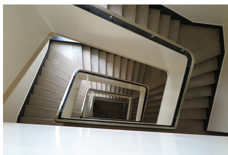
Posadzka na klatce schodowej w budynku przy ul. Świętojańskiej 44. Schody wykończone beżowo brązowym wapieniem Morawica i Bolechowice i czarnym wapieniem Dębnik.
