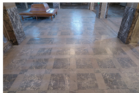
Posadzka w budynku Banku Polskiego przy ul. 10 Lutego 20-22, posadzka z wapienia Morawica oraz brunatnego wapienia kieleckiego
