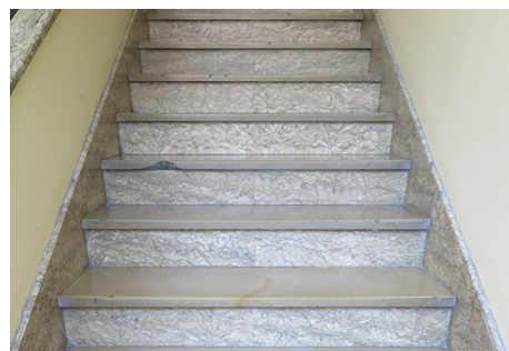
Posadzka na klatce schodowej w budynku przy ul. Abrahama 37. Płyty z wapienia mikrytowego, podstopnice i cokoły schodów z okładziny marmurowej, prawdopodobnie importowanej
