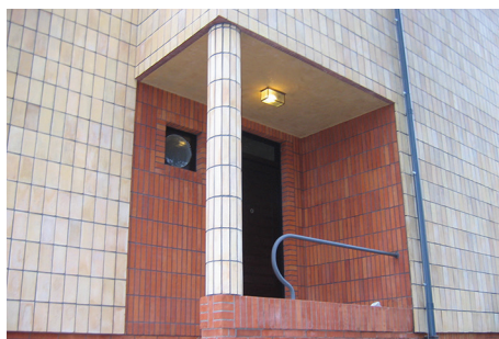
Nowoczesna oprawa oświetleniowa z lat 30. XX w. w formie prostokątnością w podcieniu wejściowym do willi w Orłowie
