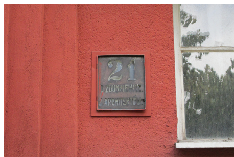
Nowoczesna podświetlana tabliczka adresowa na elewacji budynku przy ul. Architektów 21, lata 30. XX.
