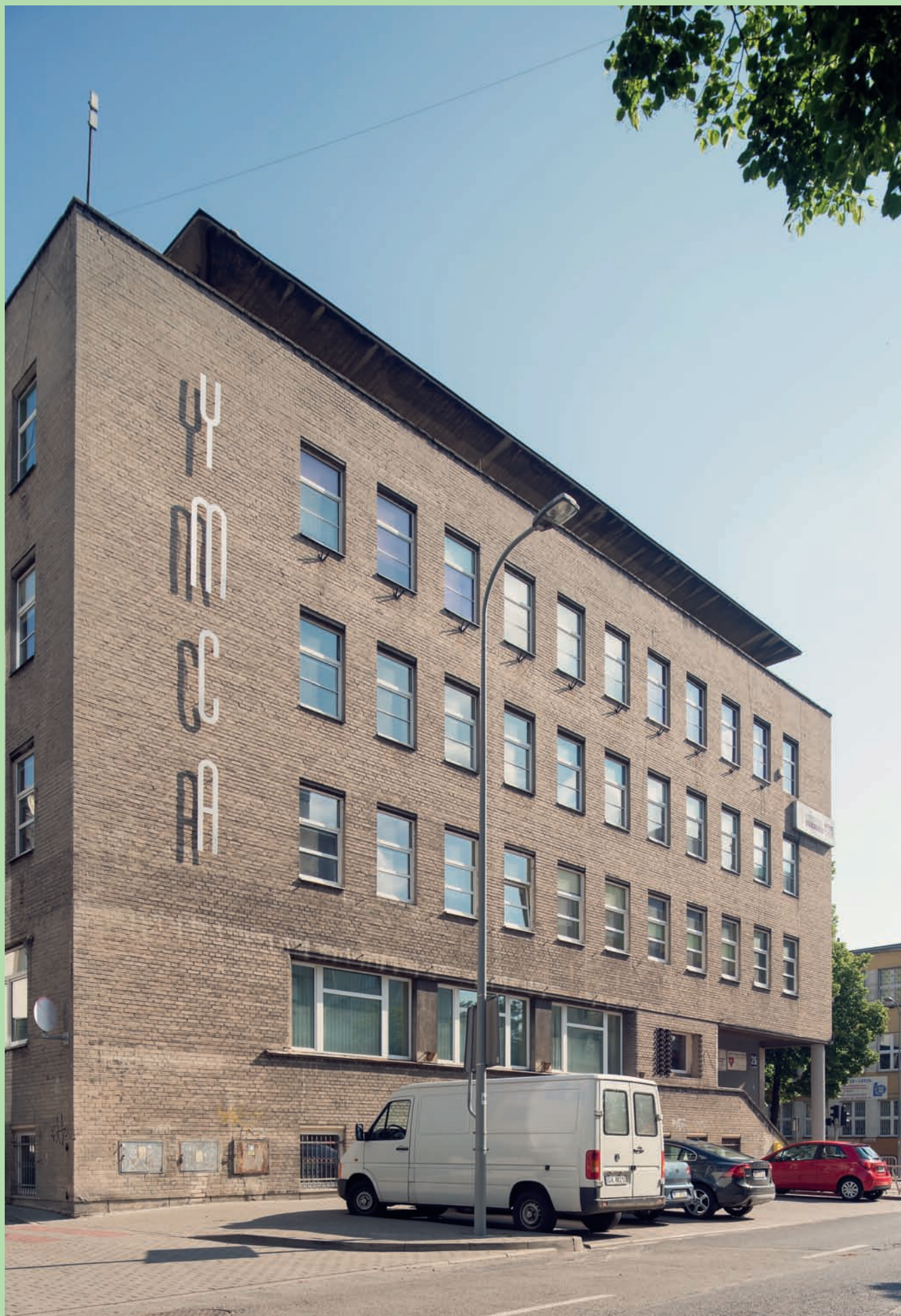
Gdynia, ul. Żeromskiego 26, budynek ogniska ZMCH „Polska YMCA” Gdynia, 26 Żeromskiego St., the building of the ZMCH “Polska YMCA”
