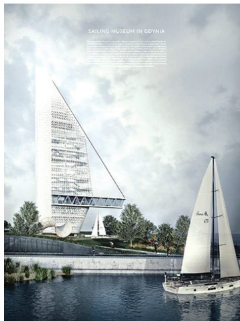
Konstrukcja budynku Muzeum Żeglarstwa jest zaprojektowana jako żelbetowa, monolityczna konstrukcja słupowo-płytowa z fundamentem na monolitycznej płycie fundamentowej na prefabrykowanych palach. Całkowita wysokość budynku wynosi 87 metrów. // fot. mat. prasowe
