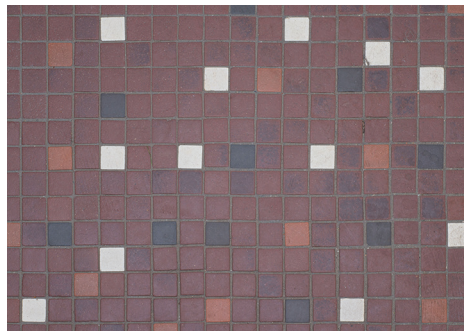
Posadzka w korytarzu budynku na Działkach Leśnych, detal różnobarwnych tzw. irysków, czyli płytek kwadratowych o długości boku 2 cm
