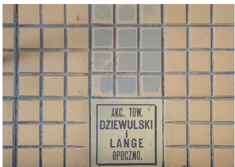
Posadzka w hali łukowej zespołu Miejskich Hal Targowych z informacją o producencie, wykonana z masywnych kwadratowych dzieliściennych płytek ceramicznych
