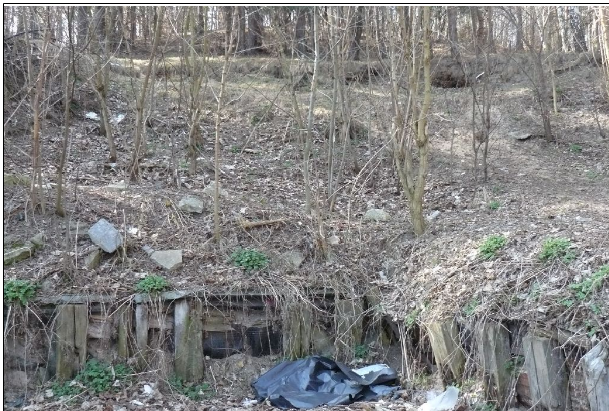
Uszkodzone zabezpieczenia przy czole osuwiska
