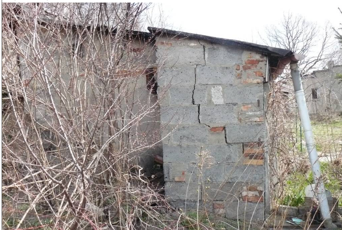
Spękania budynku gospodarczego w obrębie osuwiska
