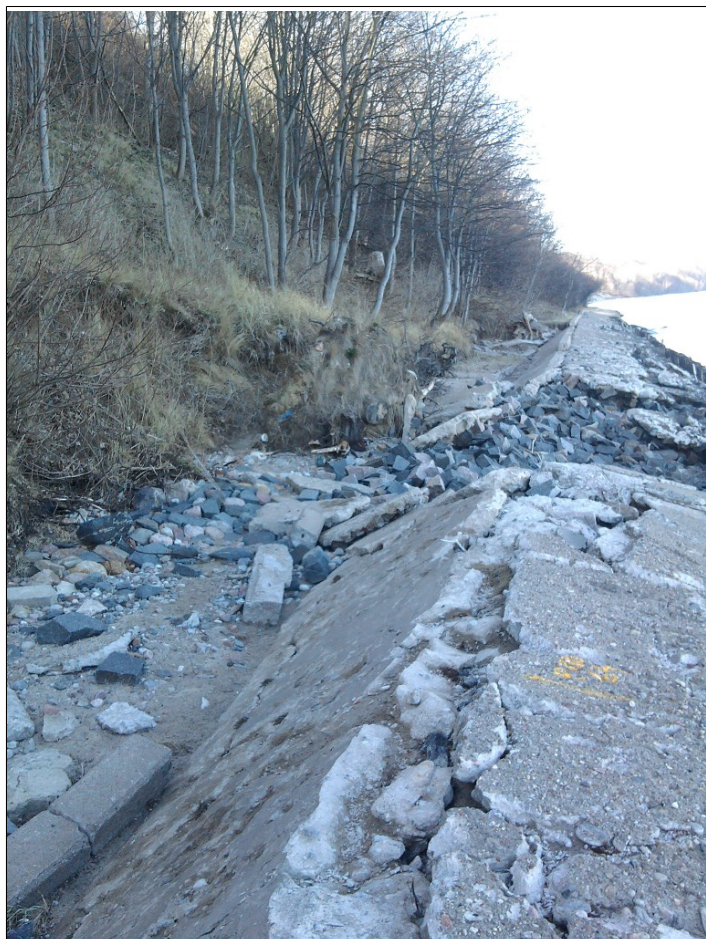
Zniszczona opaska brzegowa, ślady abrazji
