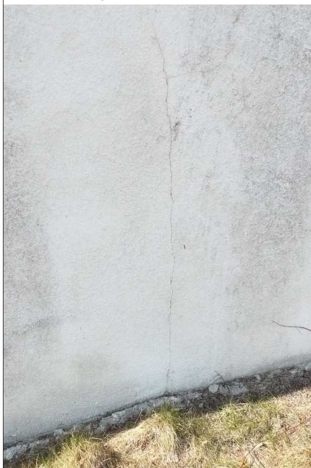
Spękany mur oporowy
