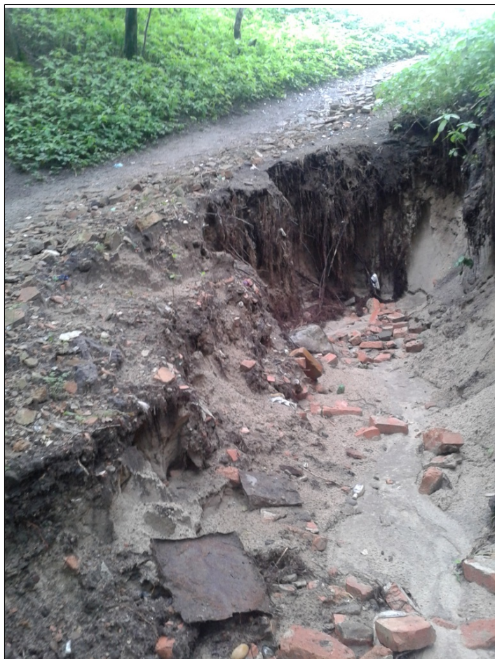
Zniszczone zejście na plażę - szczelina wewnątrzsuwiskowa
