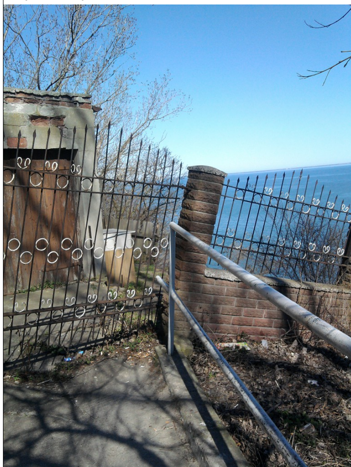
Spękany budynek gospodarczy i uszkodzone ogrodzenie powyżej osuwiska
