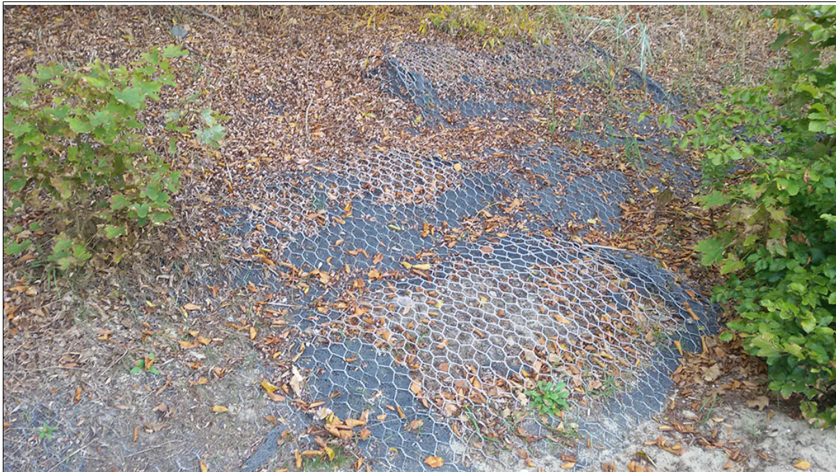
Zabezpieczenie osuwiska
