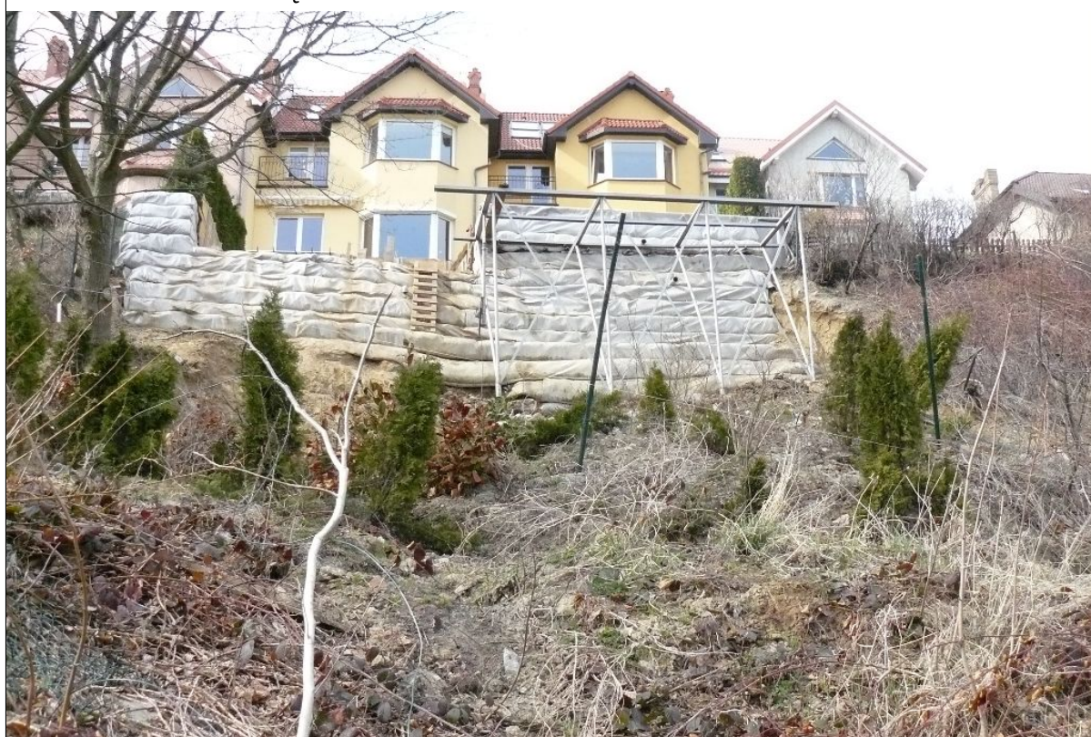
Częściowo zabezpieczona skarpa główna osuwiska
