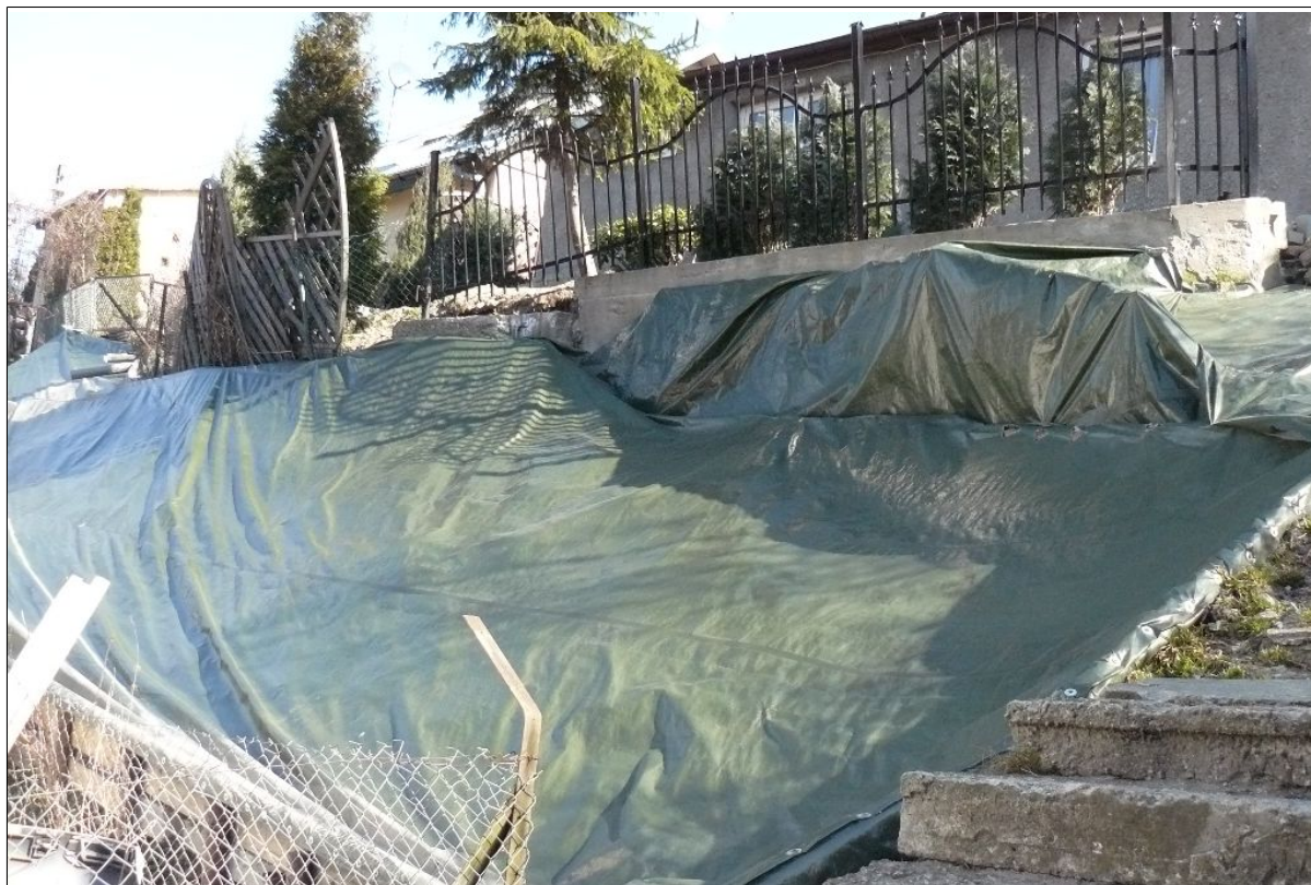
Uszkodzony płot przy skarpie osuwiska
